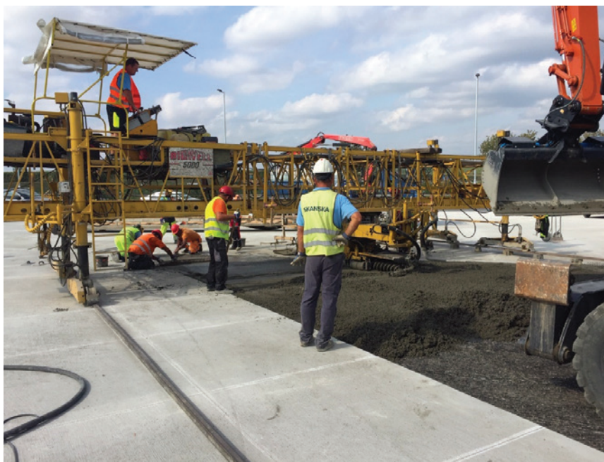
Obr. 4: Pokládka vrstvy Whitetoppingu finišerem
