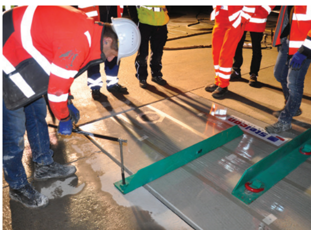
Obr. 7: Vyrovnání desky traverzami
