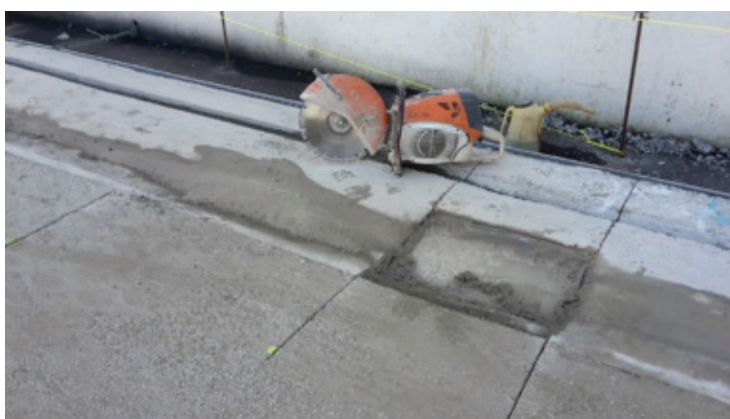
Obr. 6: Realizace aktivní kontroly trhlin řezem bezprostředně po omytí povrchu ve vzdálenosti každých 1,20 m. Ve výšce vpusti (dosud zakryté plastem) je realizován další řez.
