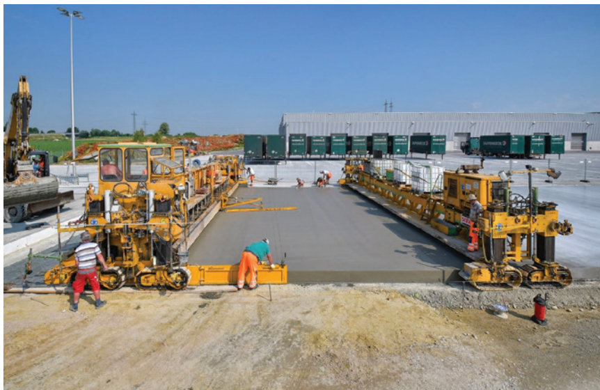
Obr. 17: Logistické centrum Wallersdorf (provedení 2017), pokládka betonu
