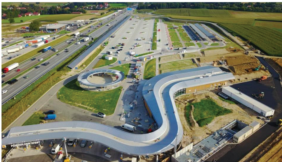
Abbildung 7: Rastanlage A9 Fürholzen-West (Ausführung 2018), modernste Rastanlage Deutschlands, Lkw-Bereich vollständig in Betonbauweise
