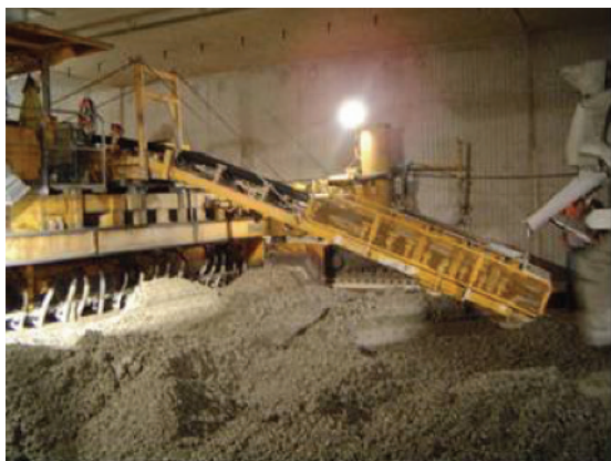
Obr. 5: Dvouvrstvý cementobetonový kryt, prováděný metodou mokrý do mokrého: dodávka betonu horní vrstvy přes první finišer s kluznými bočnicemi
