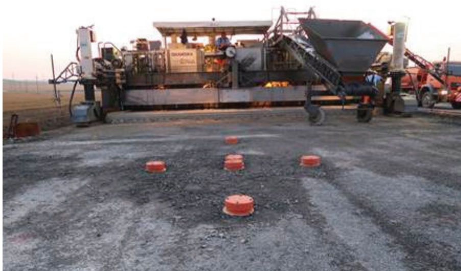
Obr 7: Betonáž CBK na pilotním úseku D1 Lipník n. Bečvou – Přerov s měřícími body.
