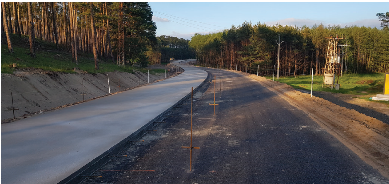
Obr. 4: Osazené kotvy v čerstvém betonu; elektrický ohradník podél denní betonáže
