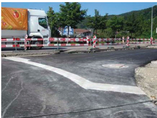
Obr. 5: Úložný práh na okružních křižovatkách pod prostorovou spárou bez kluzných trnů
