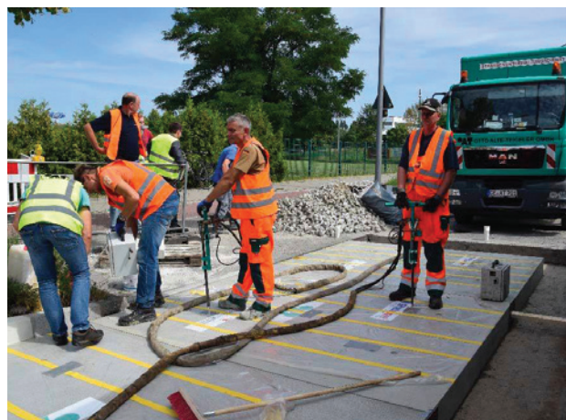
Obr. 12: Injektování silikátové pryskyřice
