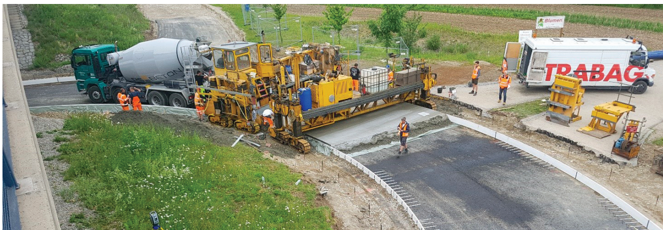
Obr. 3: Okružní křižovatka B471 v Bergkirchenu (realizace 2019), pokládka cementobetonového krytu finišerem
