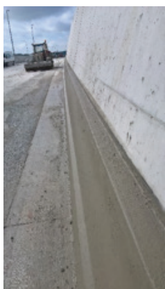
Obr. 11: Obnažení kameniva na povrchu CRCP
