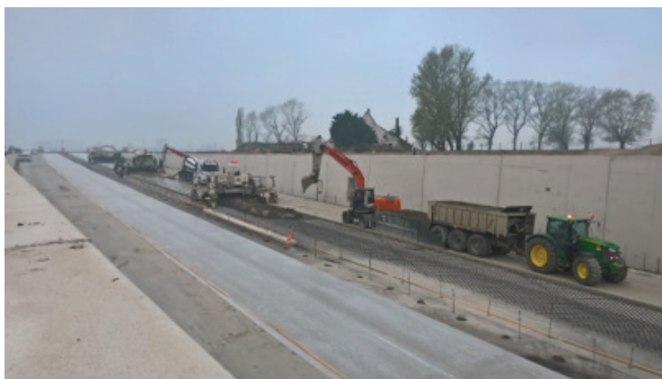
Obr. 9: Postup stavebních prací: uložení výztuže na asfaltovou vrstvu – dodávka betonu pro podklad v zásobníku – rozprostření betonu pomocí bagru – další rozprostření a zhutnění betonu pro podklad prvním finišerem s kluznými bočnicemi – dodávka betonu pro horní vrstvu v domíchávači – rozprostření betonu bagrem – další rozprostření a zhutnění finišerem s kluznými bočnicemi – nástřik zpomalovače tuhnutí a pokládka plastové fólie na povrch
