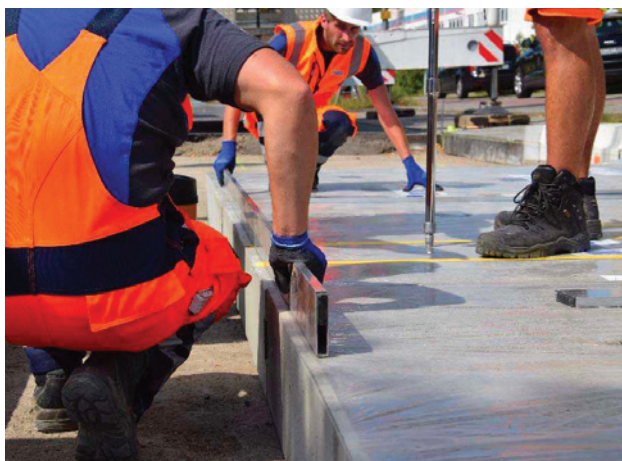
Obr. 11: Vyrovnání pomocí systému pro stanovení výšky k vyplnění dutin
