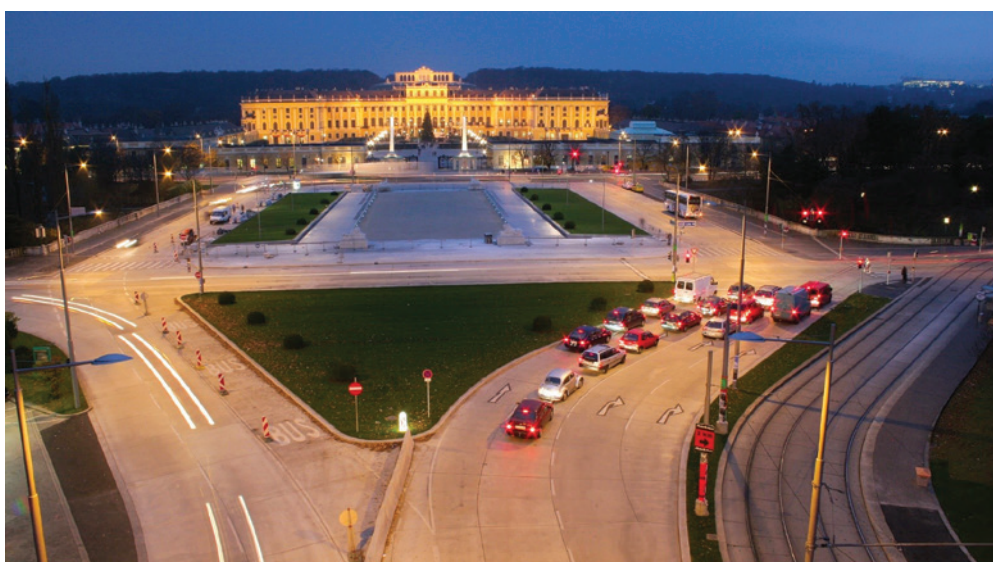
Abbildung 14: Wien, Schloss Schönbrunn, innerstädtische Betonstraßen
