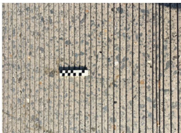
Obr. 3: Zkušební úsek NGCS v Maldegemu na N44 profil 1 (vlevo) a profil 2 (vpravo)
