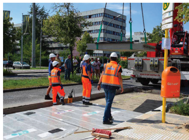
Obr. 10: Pokládka pomocí pásů
