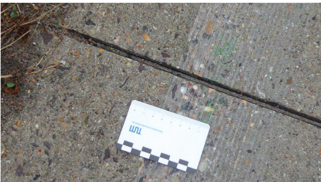
Bild 4: Durch Grinding verbesserte Oberfläche
