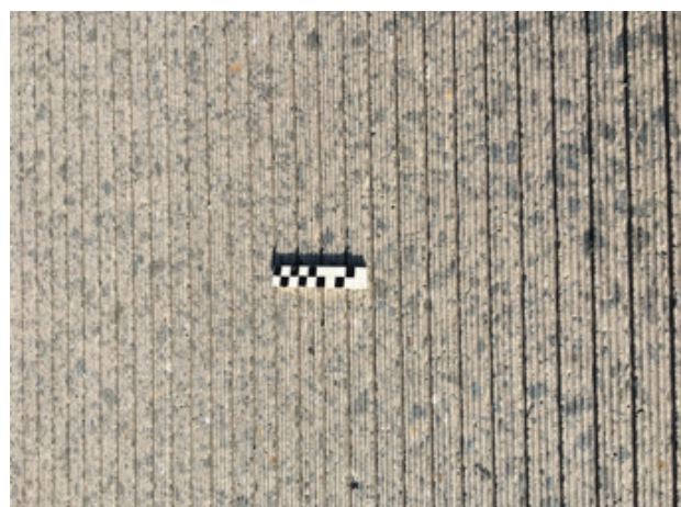
Obr. 3: Zkušební úsek NGCS v Maldegemu na N44 profil 1 (vlevo) a profil 2 (vpravo)
