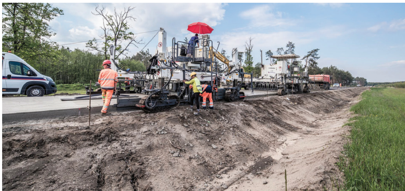
Obr. 3: Sestava finišerů Wirtgen SP 500
