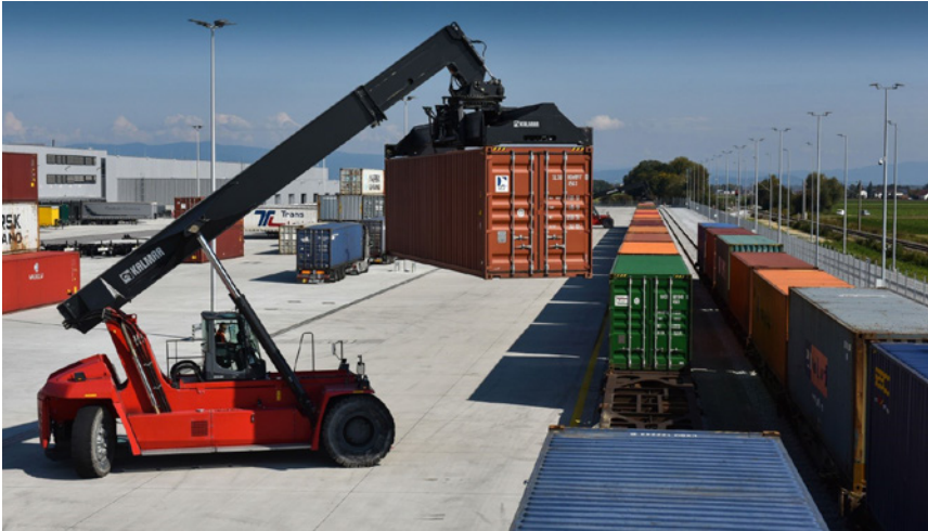
Abbildung 18: Logistikzentrum Wallersdorf (Ausführung 2017), Fläche in Betrieb
