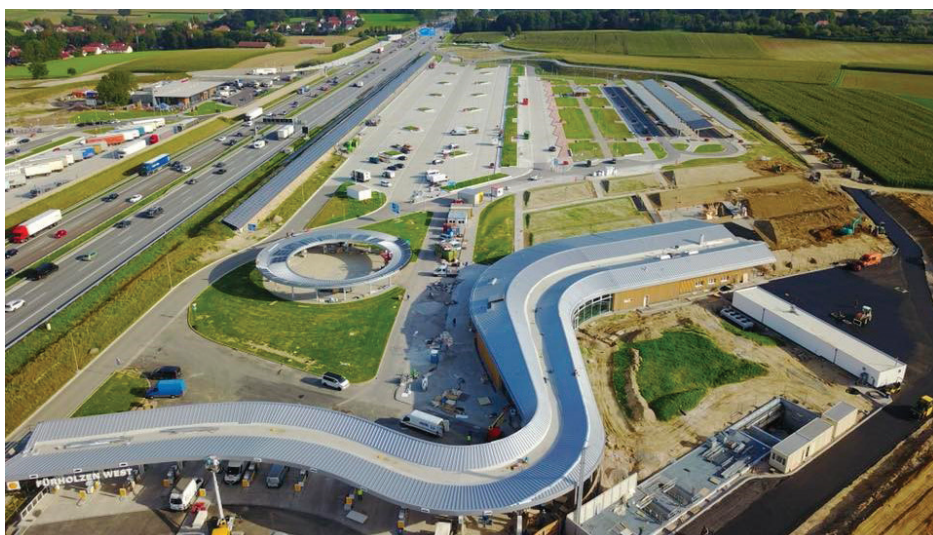
Obr. 7: Odpočívka A9 Fürholzen-West (realizace 2018), nejmodernější odpočívka v Německu, oblast pro nákladní vozidla je kompletně v betonu
