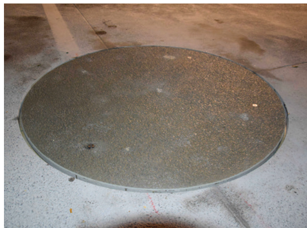
Obr. 4: Nainstalovaná kruhová prefabrikovaná deska
