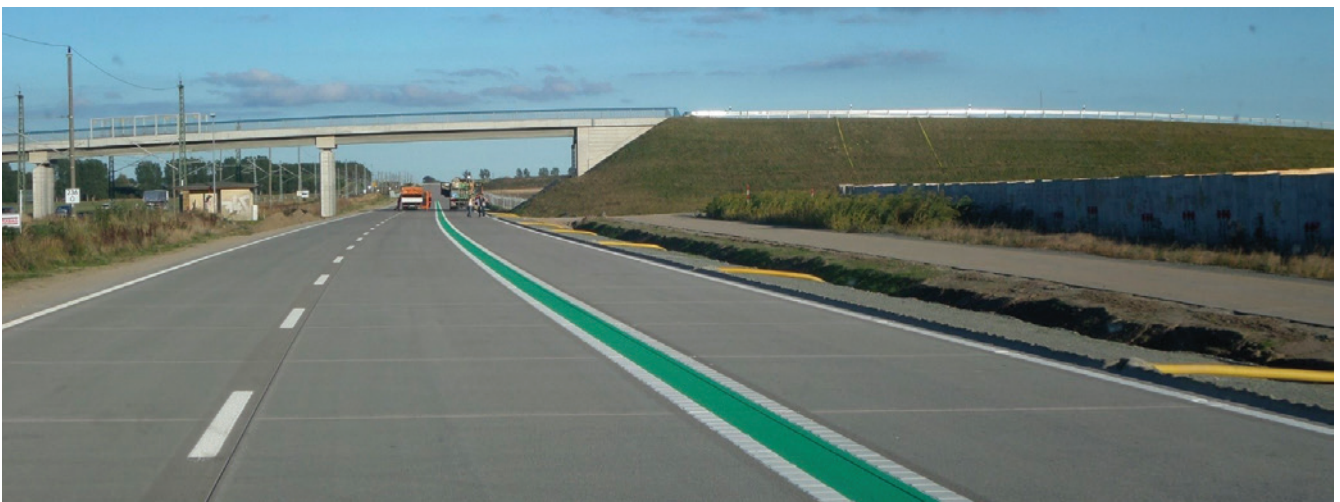
Abbildung 11: B96n Insel Rügen, Bundesstraße der Entwurfsklasse 1 (EKL 1) in Betonbauweise
