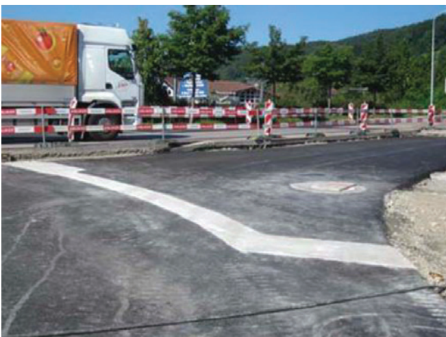
Abbildung 5: Unterlagsschwelle unter unverdübelter Raumfuge in Kreisverkehren
