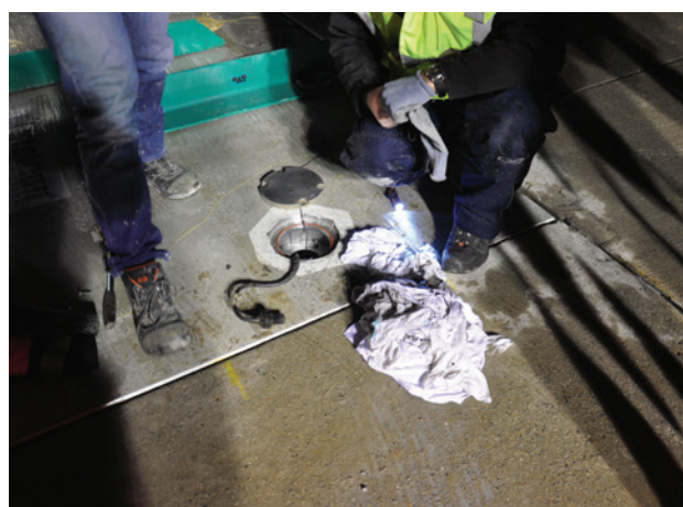
Obr. 8: Protahování kabelu světelné signalizace otvorem pro kabely
