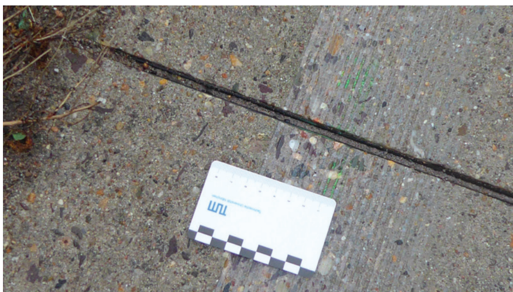
Obr. 4: Povrch zlepšený broušením
