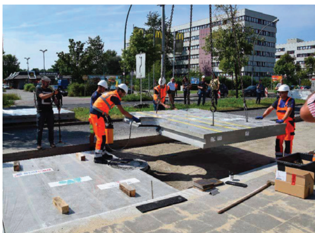
Obr. 9: Pokládka pomocí závrtných šroubů
