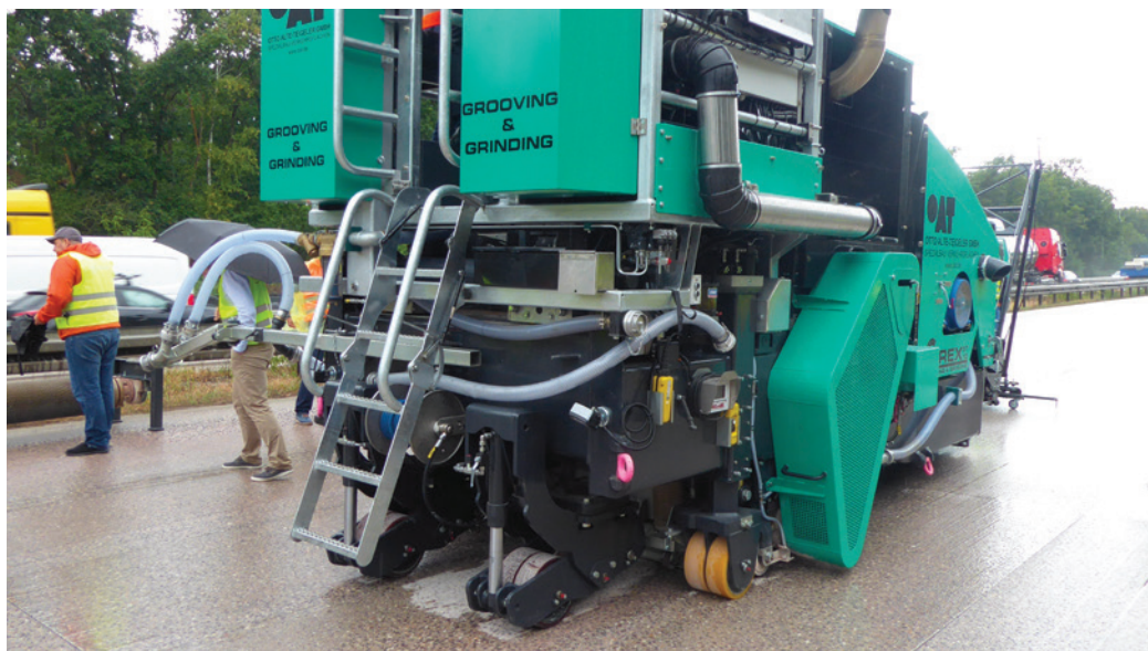
Obr. 3: Fréza s diamantovými řeznými kotouči pro obnovu rovnosti, drsnosti a snížení hluchosti
