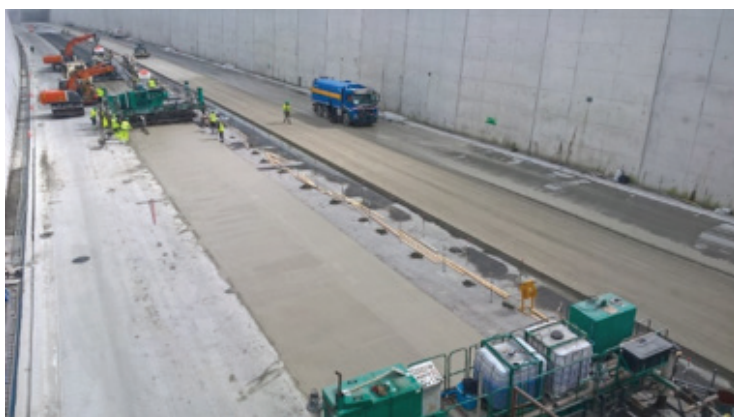
Obr. 7: Realizace dvouvrstvového cementobetonového krytu na zahloubené komunikaci a v tunelu
