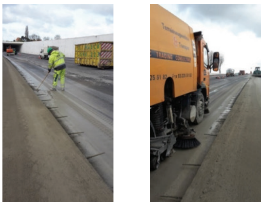
Obr. 12: Čištění asfaltové vrstvy vedle čerstvě položeného cementobetonového krytu po vymývání povrchu
