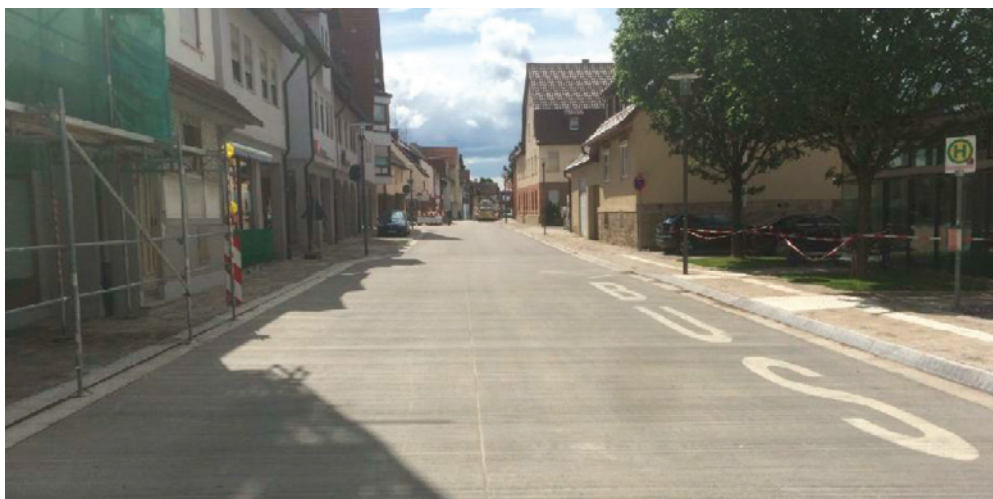
Obr. 13: Weil im Schönbuch, průtah obcí v betonové technologii
