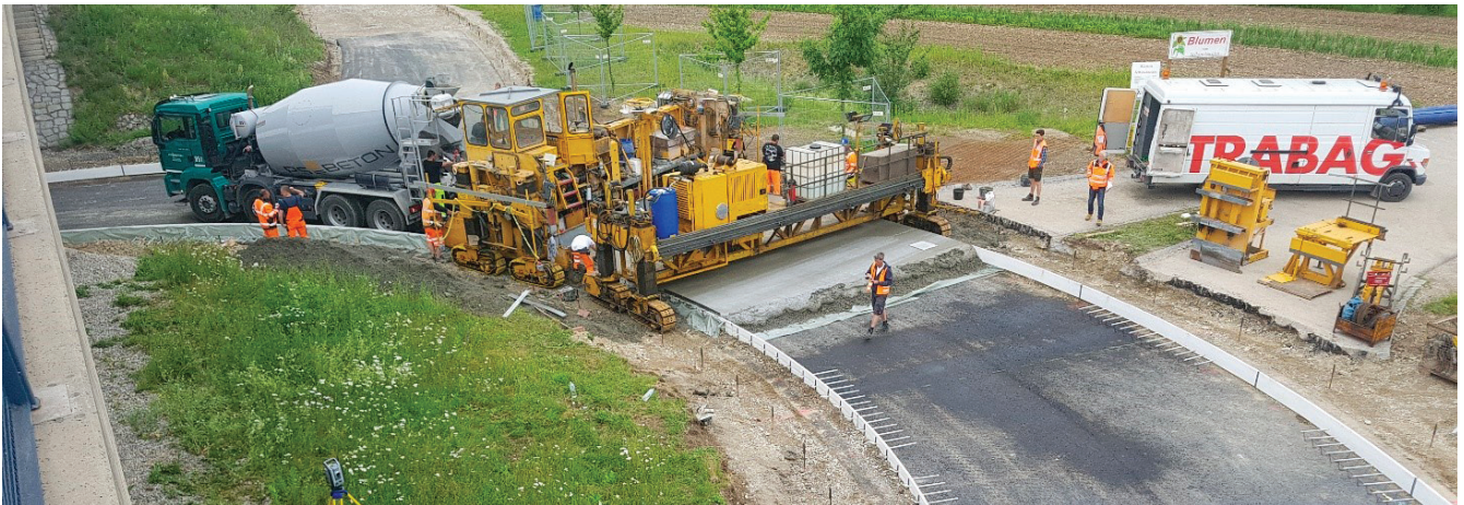
Abbildung 3: Kreisverkehr B471 Bergkirchen (Ausführung 2019), Betoneinbau der Kreisfahrbahn mit Fertiger
