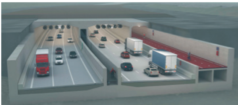
Obr. 15: Tunel pod řekou Šeldou s CRCP jako krytem vozovky
