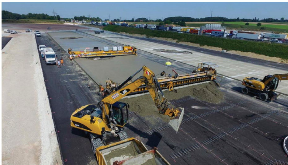
Abbildung 6: Rastanlage A5 Bühl-Ost (Ausführung 2017), Betoneinbau der Lkw-Schrägparkständen mit Fertiger (Einbaubreite 18m)
