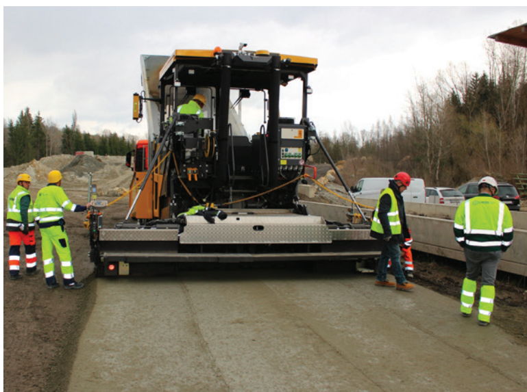
Obr. 2: Finišer s vysokým stupněm zhutnění
