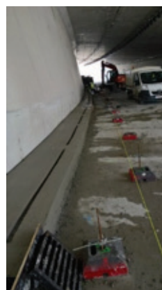
Obr. 7: Realizace dvouvrstvového cementobetonového krytu na zahloubené komunikaci a v tunelu
