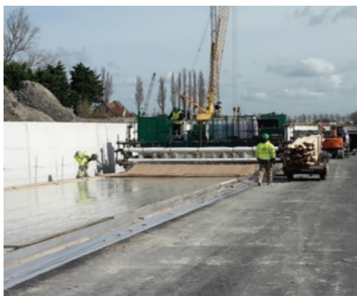
Obr. 10: Položení a zajištění plastové fólie pomocí dřevěných trámek
