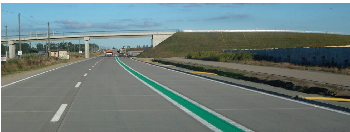
Obr. 11: B96n ostrov Rujána, státní silnice I. třídy (EKL 1) betonovou technologií
