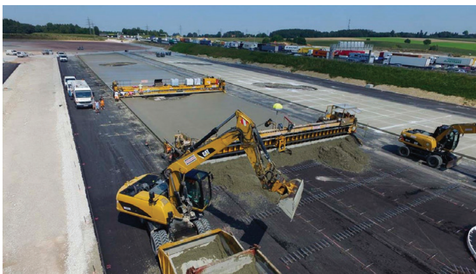
Obr. 6: Odpočívka A5 Bühl-Ost (realizace 2017), pokládka betonu šikmých odstavných ploch pro nákladní vozidla finišerem (šířka pokládky 18 m)
