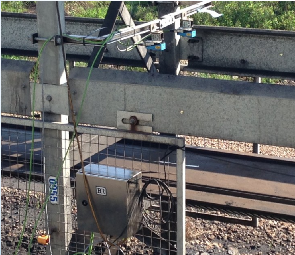
Kamera namontovaná na svorku snímacího pásu
