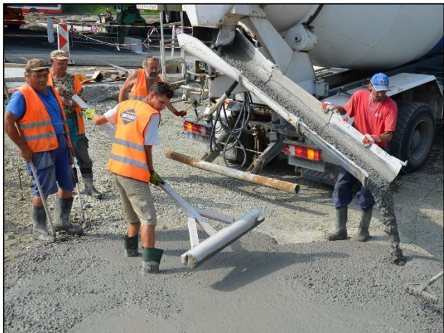
Optimalizace trati – podkladní betony.
