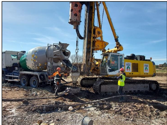
Experimentální ověření betonáže pilot s RA.
