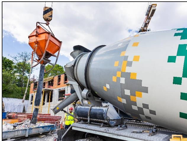
VESI Hostivař – podkladní betony a stěnové konstrukce.
