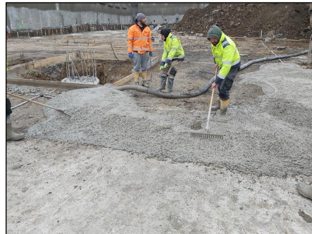
Lití podkladních betonů.
