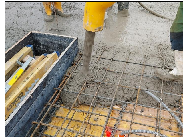
Lití stropních konstrukcí.
