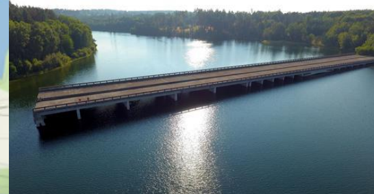
Most přes Sedlický potok
