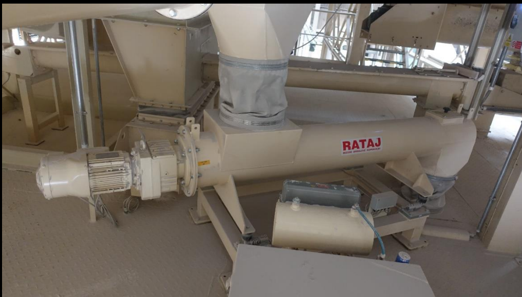
Knauf Počerady – průběžná váha jílu – 4,6 t/hod
