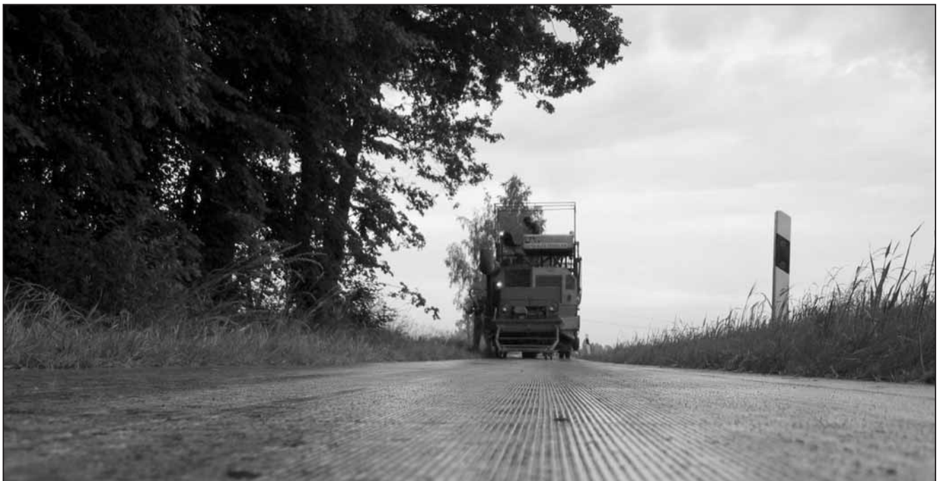
Bild 5: Griffige, lärmarme Betonoberfläche nach Grinding
