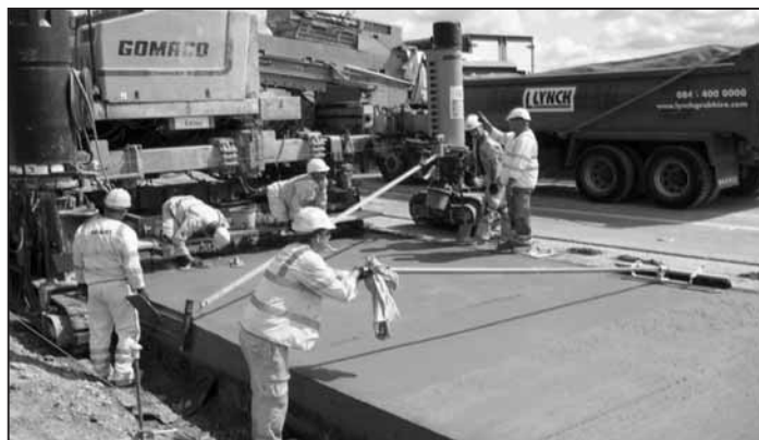
Finišer Gomaco pokládající novou vrstvu cementobetonového krytu
