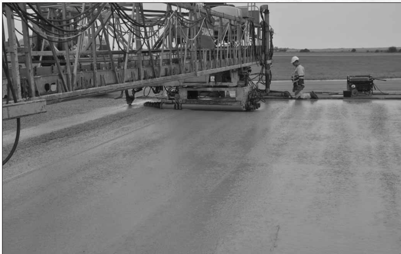
Obr. 5. Betonáž desky za pomoci „rychlých“ betonů
