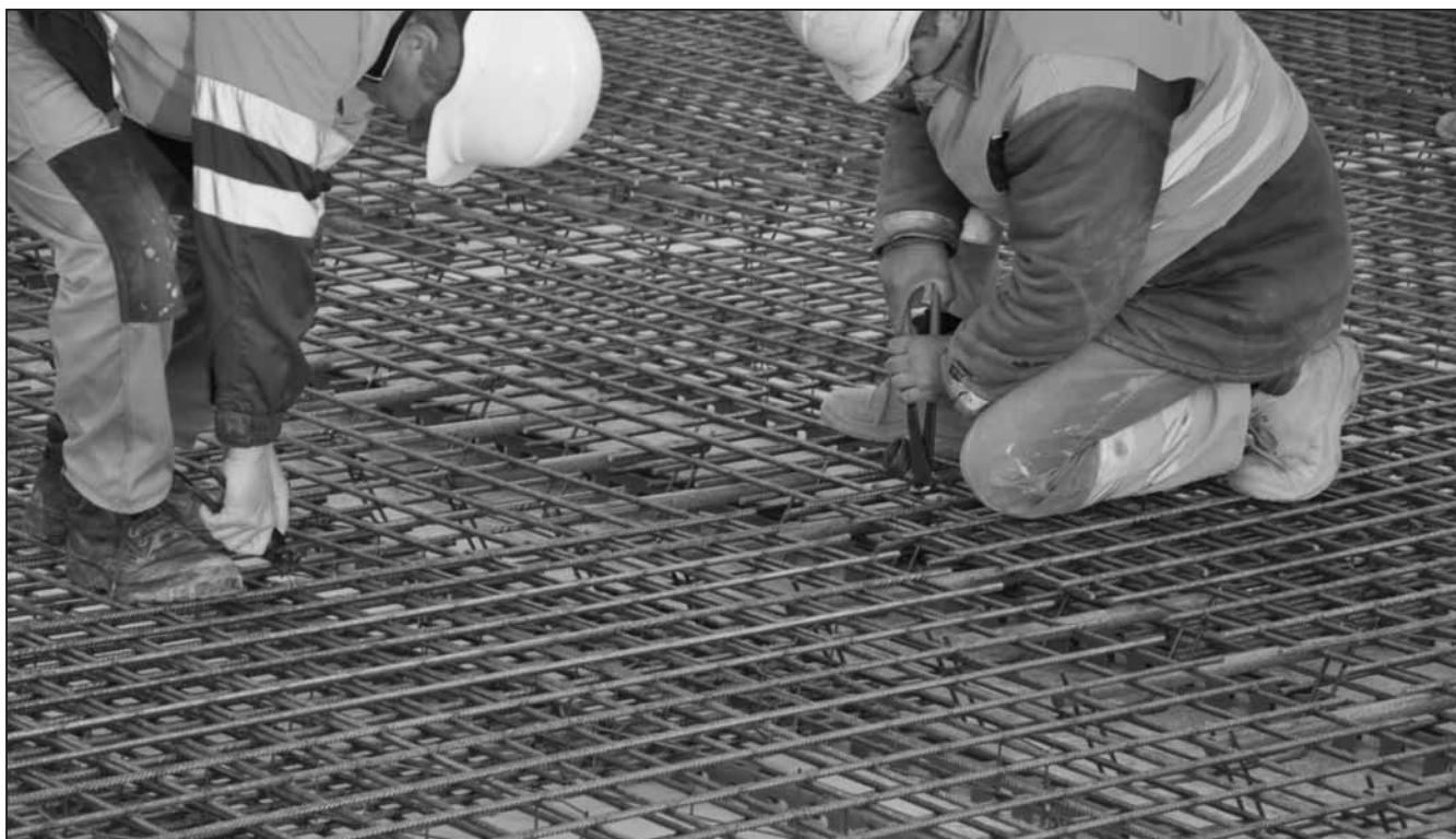
Obr. 4. Příprava desky na betonáž – armování
