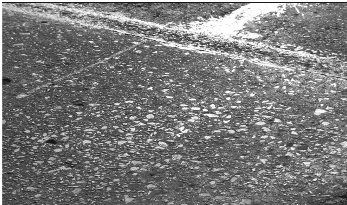
Obrázek 2 – Obnažení a vyhlazení hrubého kameniva na povrchu CBK
