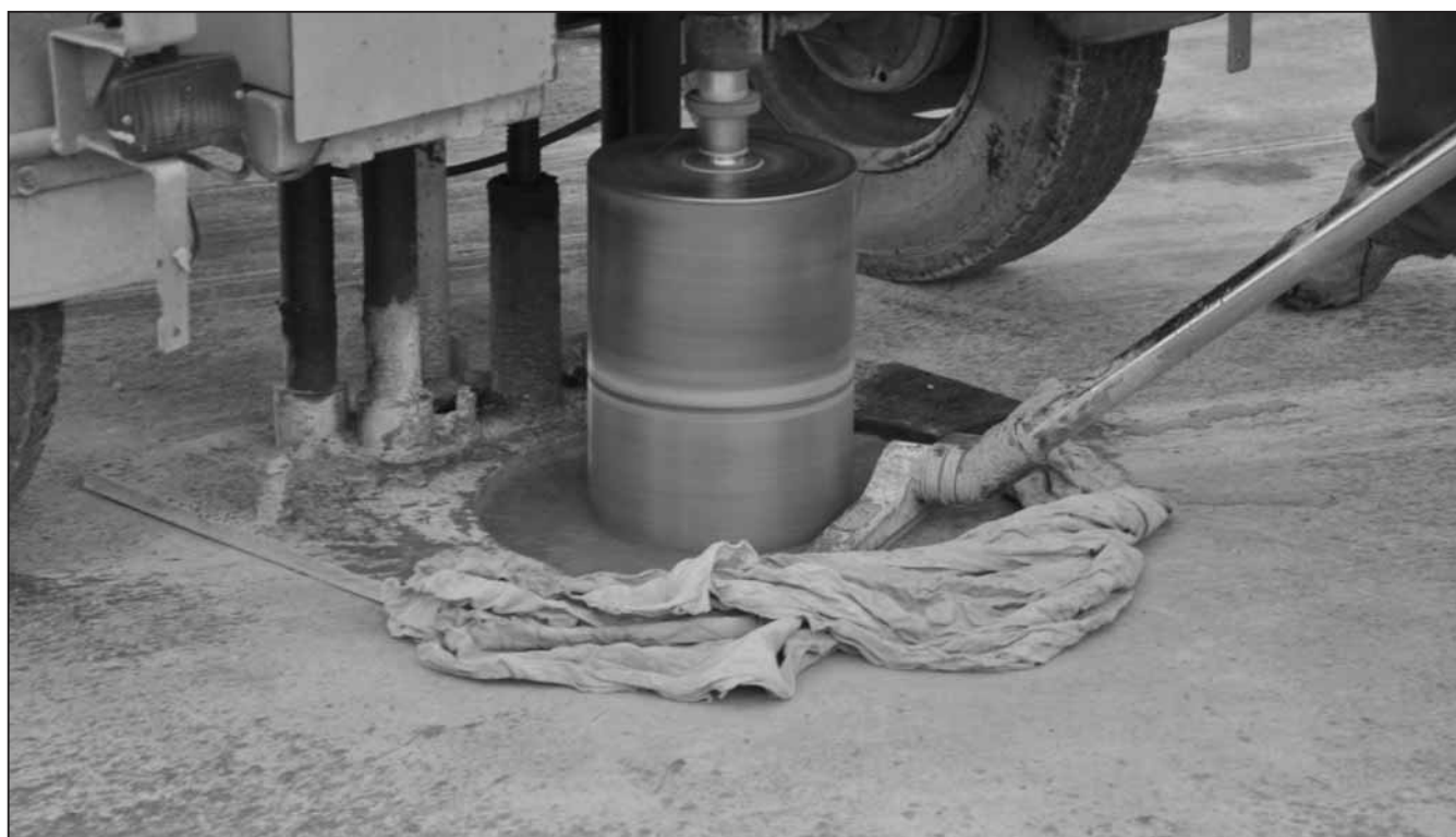
Obr. 6. Příprava otvorů pro novou světelnou signalizaci
