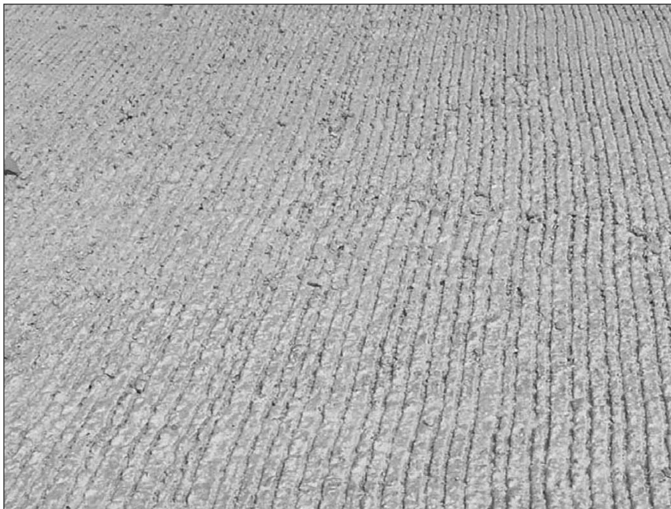
Obrázek 18 – Rychlostní silnice R1, km 77,440 – 77,656, pokusný úsek zdrsnění vlečenou jutou a příčným drážkováním
