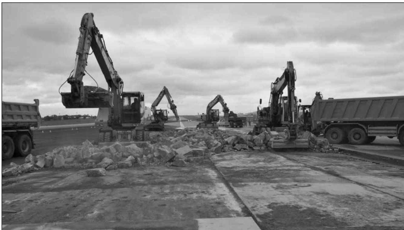
Obr. 3. Bourání staré poškozené betonové desky
