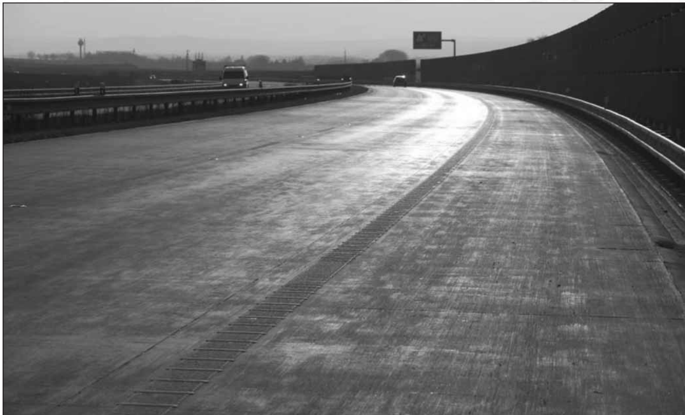
Obrázek 4 – Povrch CBK s úpravou vlečenou jutou po 4 letech provozu
