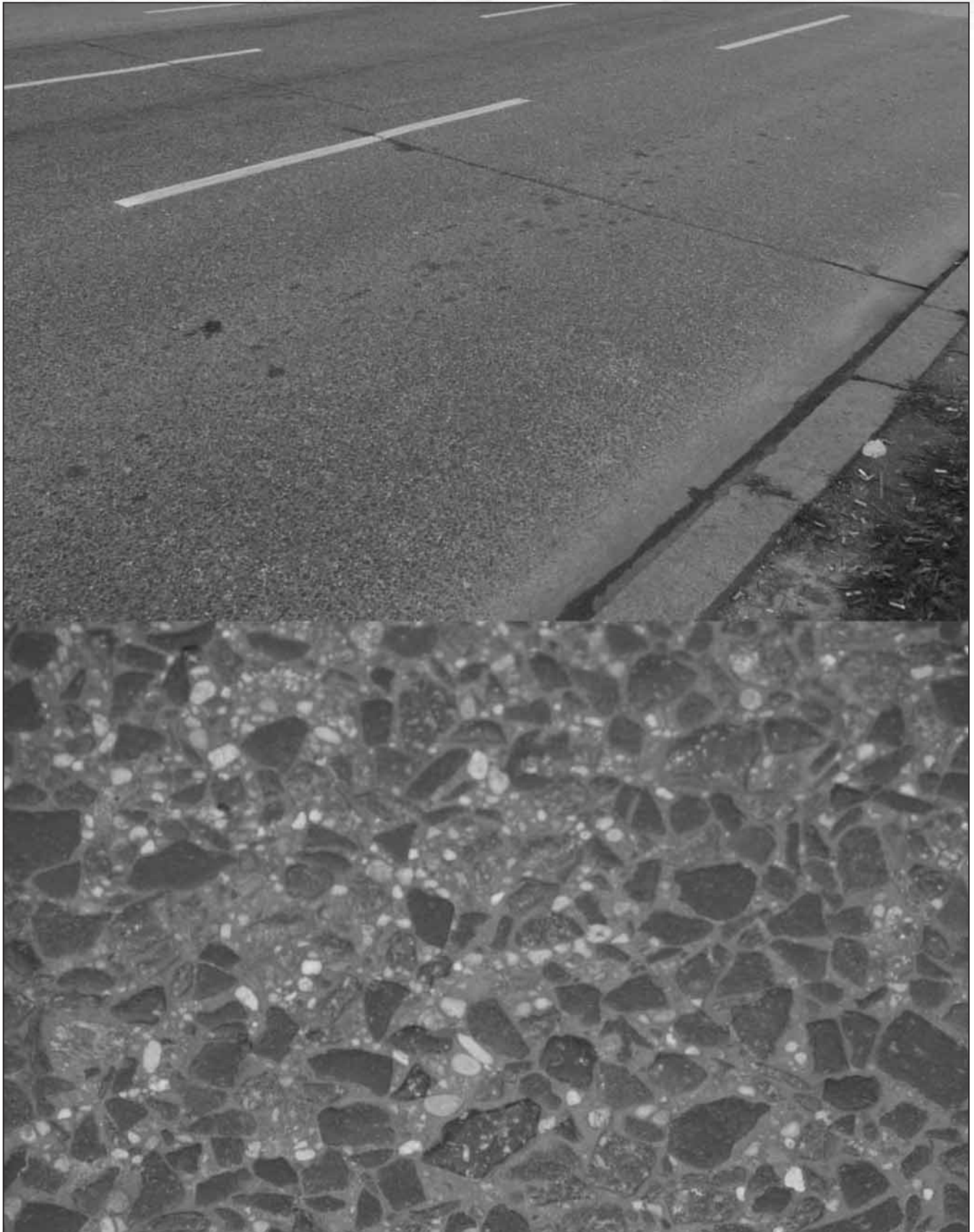
Obrázek 5 – Čedičové kamenivo s nevyhovujícím PSV na vídeňském městském okruhu
