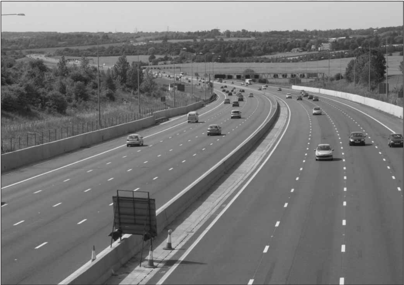
Úsek dokončené dálnice se 4 jízdními pruhy v každém směru, který zahrnuje většinu betonových prvků použitých na projektu M25 zhotovených pomocí technologie posuvného bednění.
