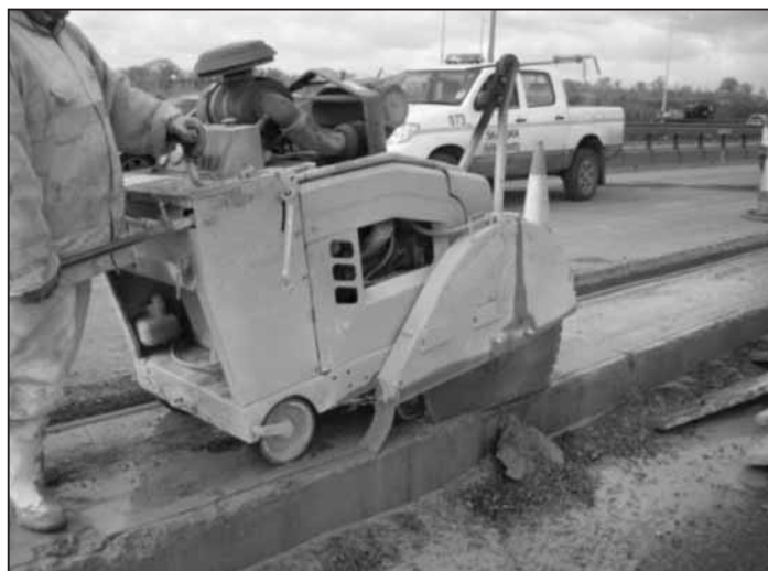
Odřezávání hrany vozovky
