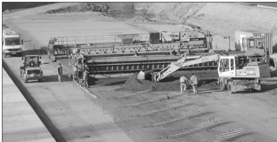
Obrázek 2: Provedení dopravní plochy z betonu na odpočívce
