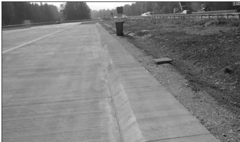
Obrázek 15: Ukotvený monolitický obrubník staveništního betonu
