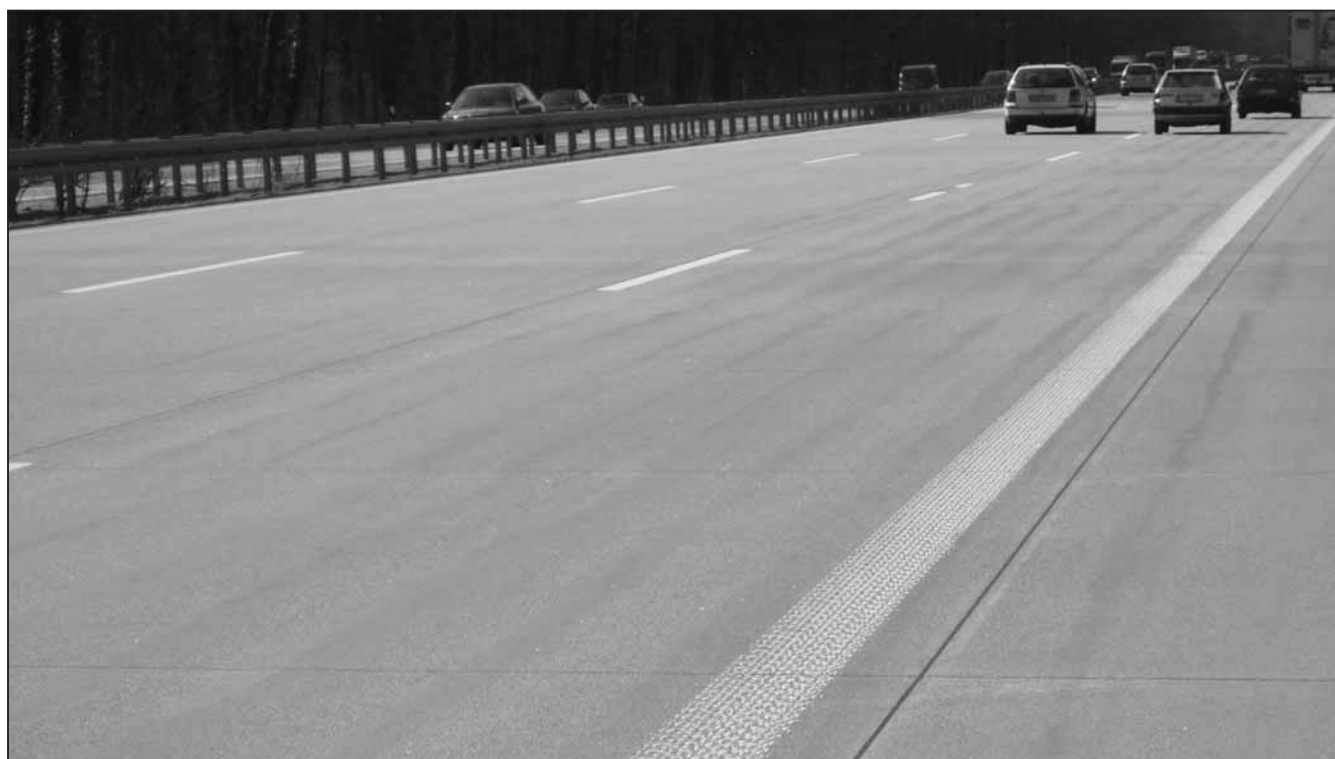
Bild 2: Waschbetonfahrbahn
