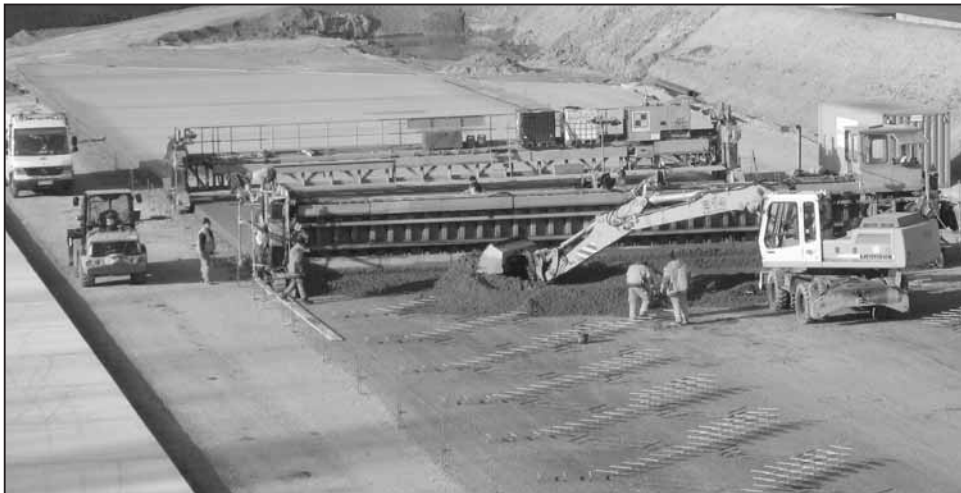
Bild 2: Ausführung einer Verkehrsfläche aus Beton auf einer Rastanlage
