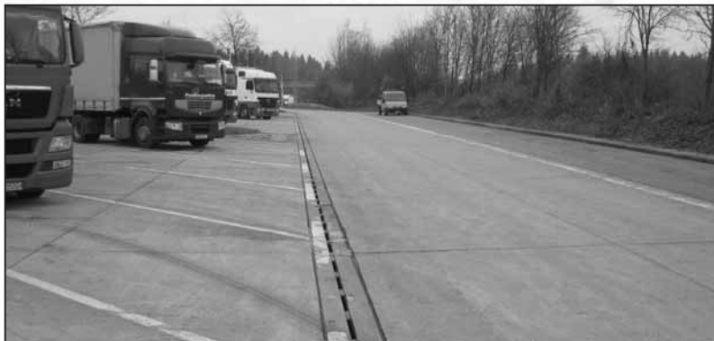
Obrázek 17: Starší stávající odpočívadlo s jízdním pásem z betonu (BAB A7, zařízení pro tankování a odpočinek Lonetal)
