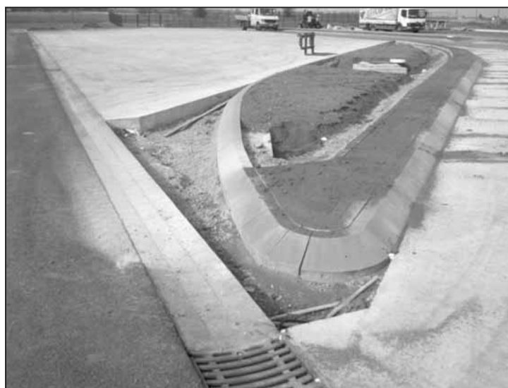
Obrázek 11: Plocha klínového tvaru vzniklá z důvodu nevhodného tvaru ostrůvku
