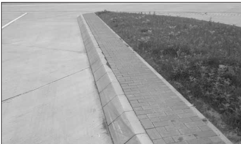
Bild 14: Monolithische Weiterführung der Betondecke mit aufgeklebten Bordsteinen
