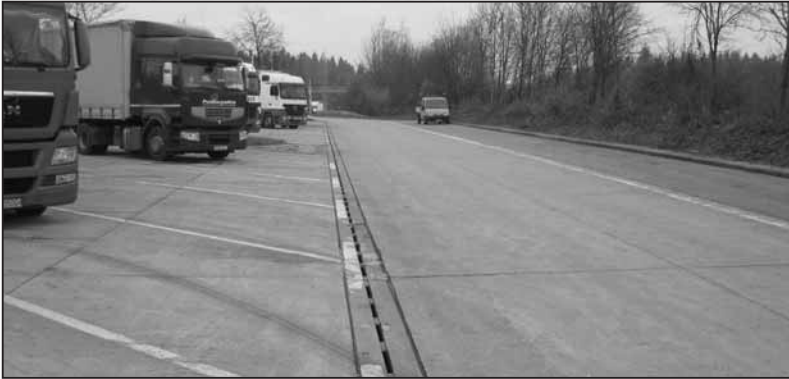
Bild 17: Ältere bestehende Rastanlage mit Fahrgasse aus Beton (BAB A7, T+R-Anlage Lonetal)
