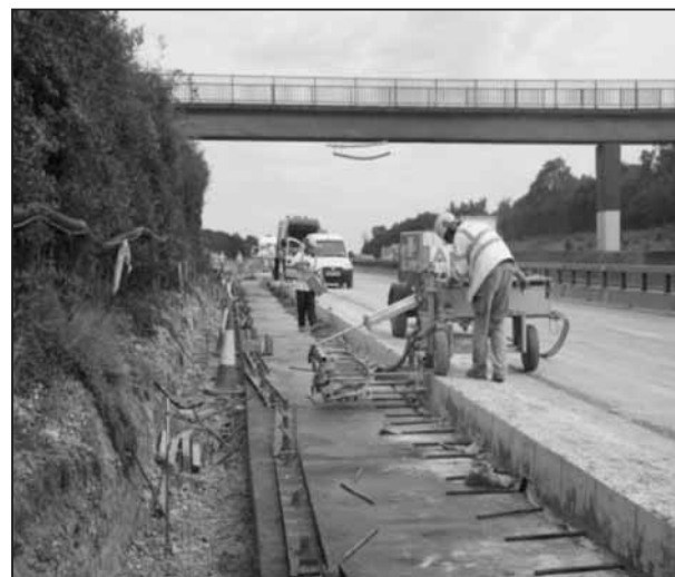
Osazování kotevních tyčí
