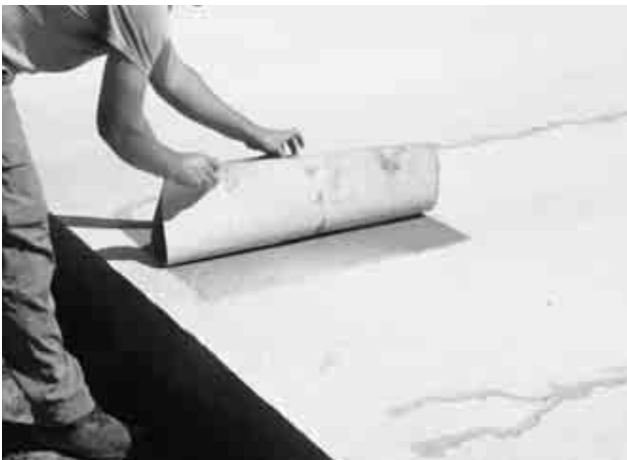
Obr. 5 Určování nástřikem nanášeného množství kombinovaného prostředku pro zpomalování tuhnutí a ochranu proti vysychání zpětným vážením fólie
