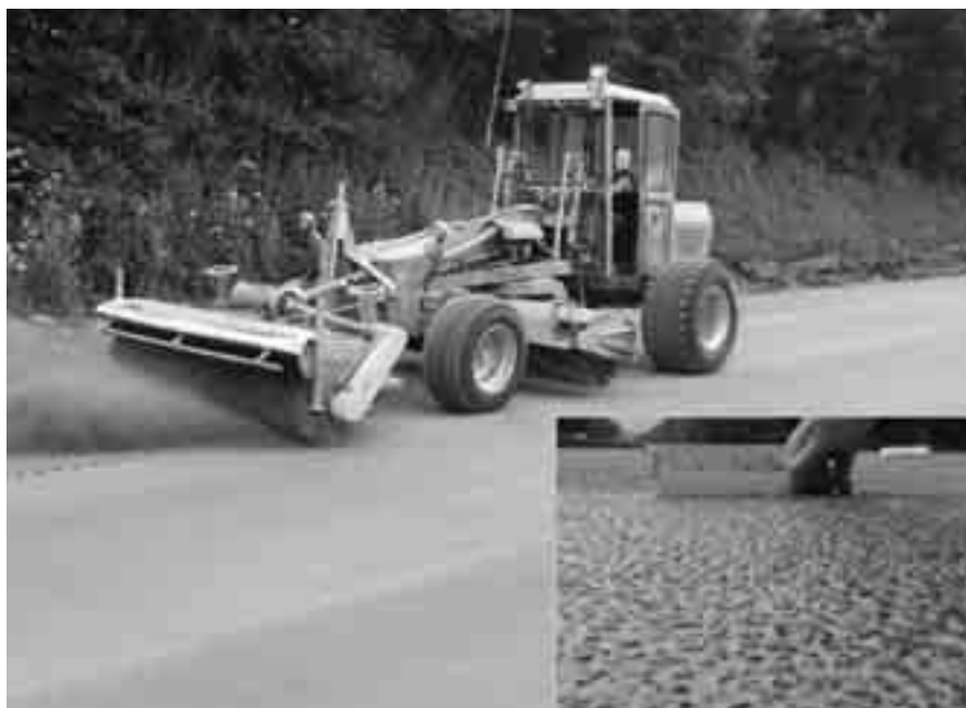
Obr. 6 Kartáčování povrchové malty pomocí pojízdného ocelového kartáče a vykartáčovaný povrch s obnaženým zrnem frakce 5/8 mm
