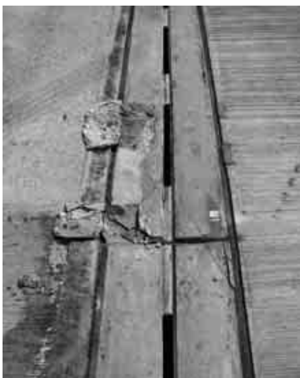
Poškození povrchu žlabu, které může způsobit včasné nevyčištění a neutěsnění styčné dilatační spáry
