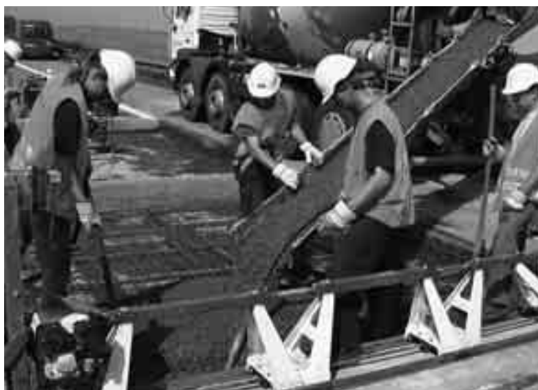
Obr. 3. Betonáž desky za pomoci „rychlých“ betonů
