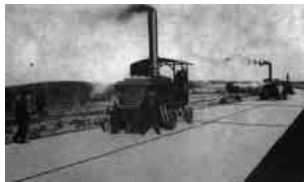
Obr. 2 Finišery Guntert – Zimmerman systémem DBI vybaveny nebyly
