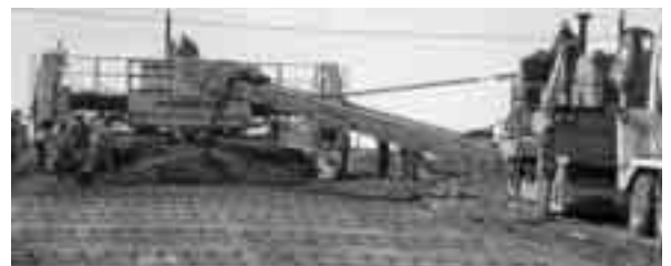
Obr. 8 Doprava betonové směsi z vedlejšího pruhu je nezbytným řešením při tomto způsobu instalace kluzných trnů
