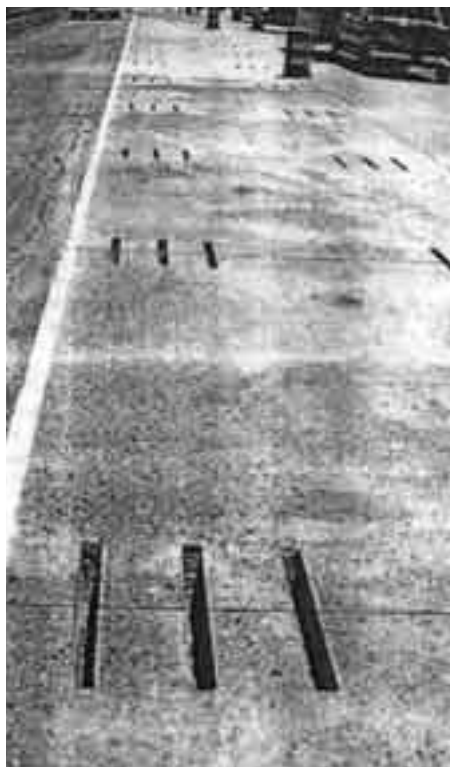
Obr. 12 Vyřezované drážky pro dodatečné vkládání kluzných trnů nepůsobí na vozovce ani esteticky ani bezpečně i při sebelepši aplikaci
