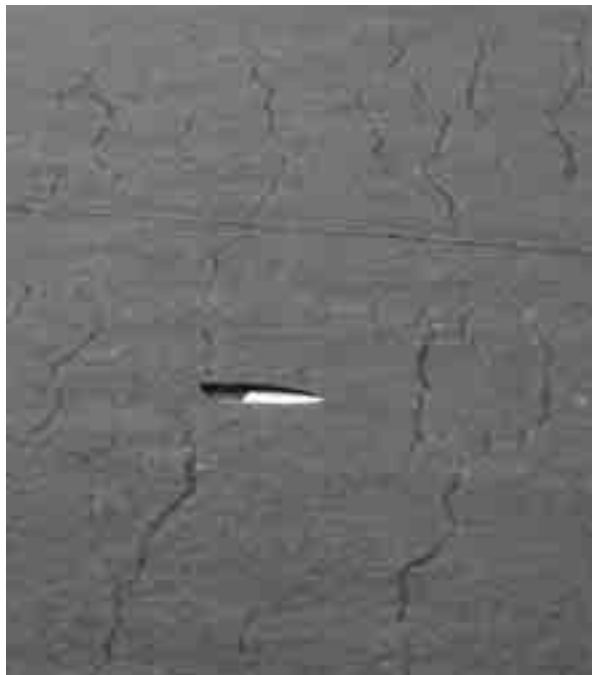
Obr.3: 2003 – soustava příčných trhlin
