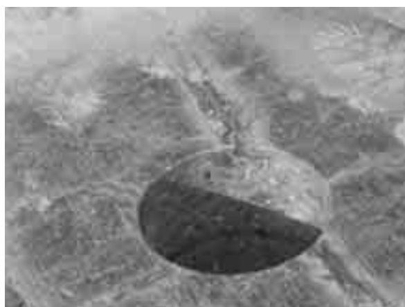
Obr. 8: 2004 – otvor po vývrtu 10/DSP/04, mozaika, aktivní trhлина
