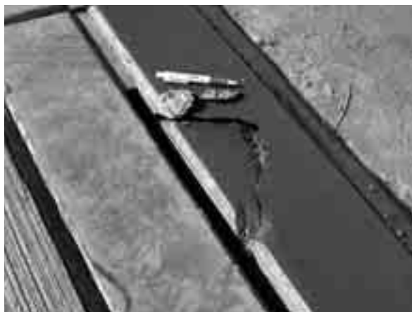
Poškození betonového štěrbinového žlabu umístěného na styku nové (vlevo) a staré (vpravo) vozovky v ploše široké celkem 375 m ve směru kolmém na žlab
