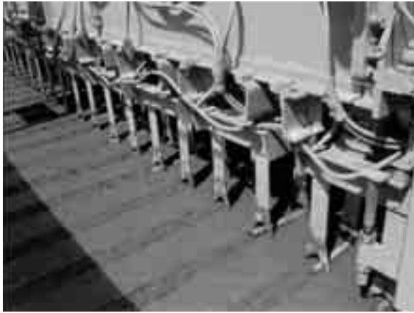
Obr. 5 Finišer CMI SF – 550, vidlice DB1, přesně rozmístěné a vtačované kluzné trny v první vrstvě
