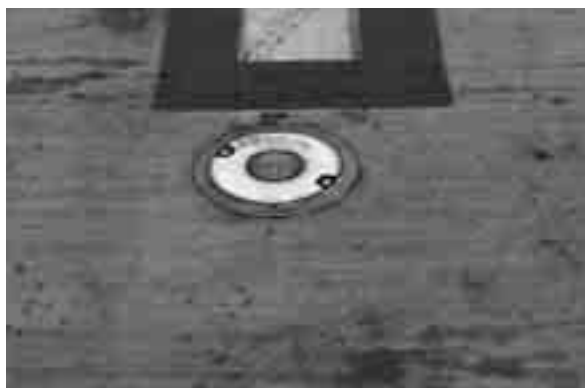
Příklad zapuštěného návěstidla v letištní vozovce
