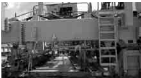
Obr. 3 První DBI systém na mohutném rámu finišeru GOMACO GP 3000 v roce 1989
