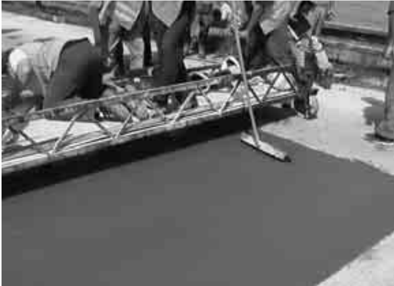
Obr. 4. Provedení zdrsnění povrchu vozovky
