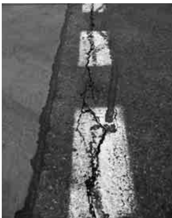
Trhliny na styku živичné a cementobetonové vozovky
