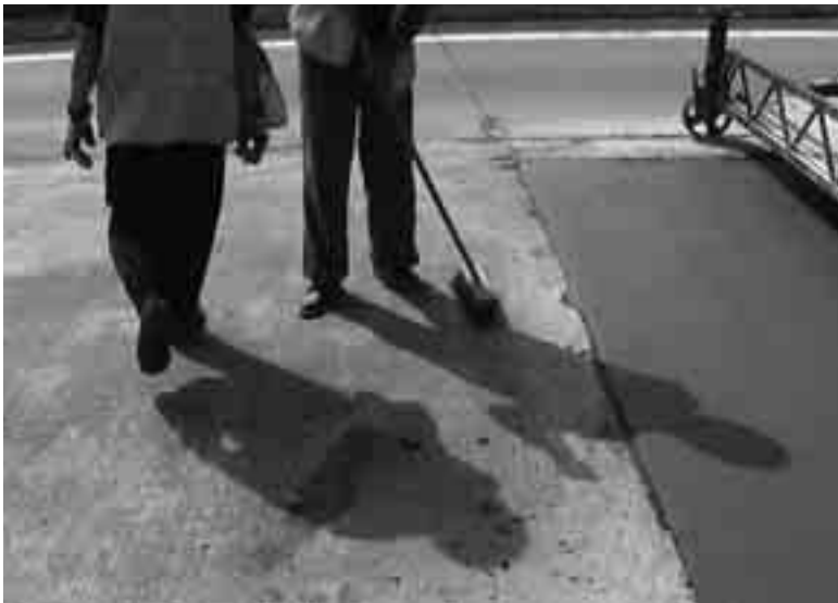
Obr. 5. Těsně po betonáži je důležité vše precizně uklidit.
