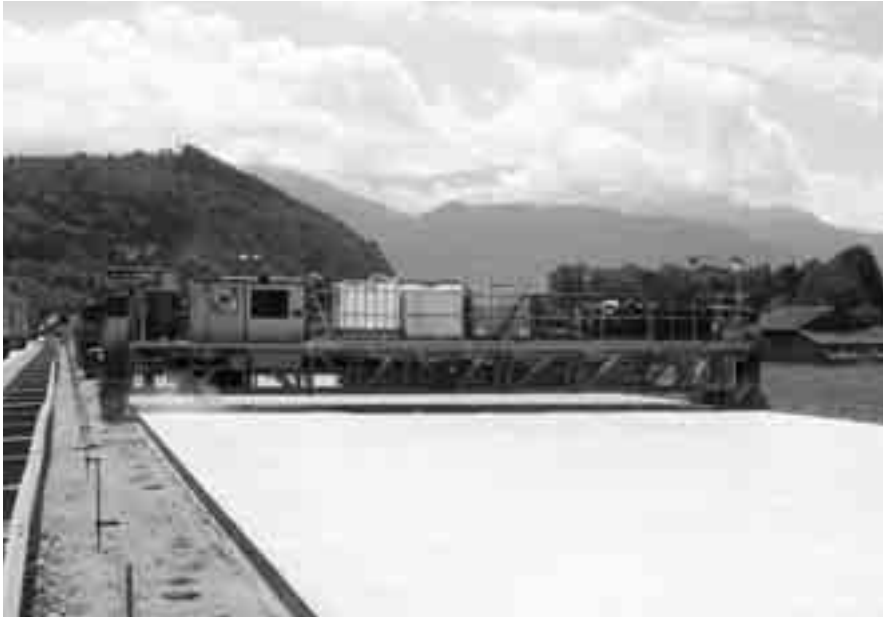
Obr. 4 Nanášení kombinovaného prostředku pro zpomalování tuhnutí a ochranu proti vysychání povrchu nástřikem z pracovní plošiny
