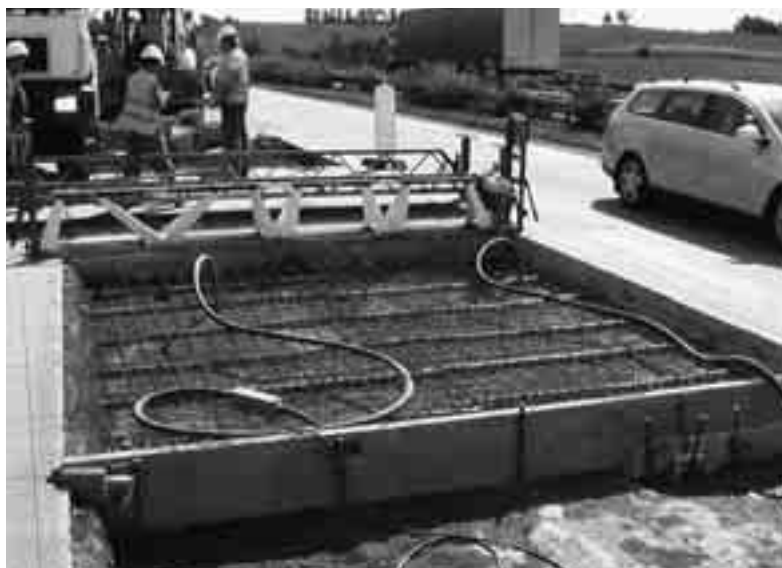
Obr. 2. Deska připravená na betonáž
