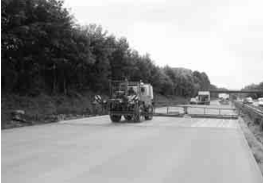
Bild 7 Weiterführende Nachbehandlung der ausgebürsteten Fahrbahnoberfläche durch Aufsprühen eines herkömmlichen Nachbehandlungsmittels von einem mobilen Trägergerät aus
