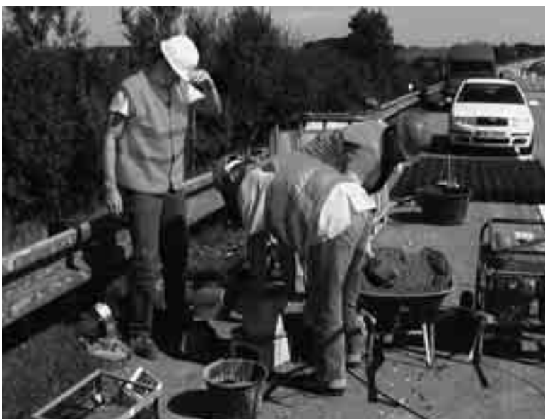
Obr. 6. V průběhu betonáže je prováděna řada kontrolních zkoušek a měření.
