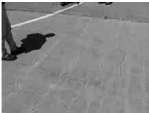
Obr.1: 2002 – soustava příčných trhlin
