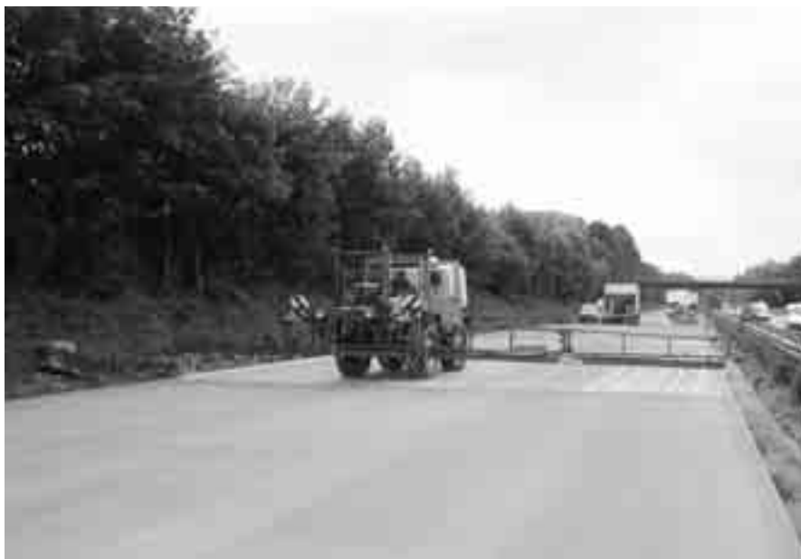
Obr. 7 Další konečný nástřik prostředku proti vysychání (který byl používán i doposud) na vykartáčovaný povrch vozovky pomocí mobilního zařízení
