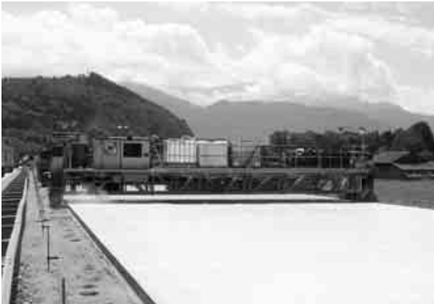
Bild 4 Aufsprühen eines kombinierten Verzögerungs- und Nachbehandlungsmittels von einer Arbeitsbühne aus
