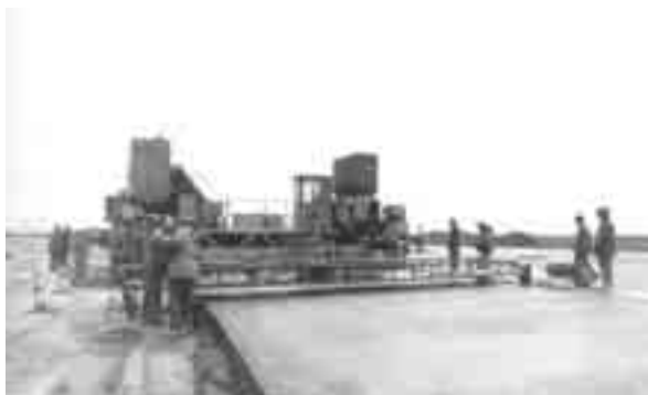
Obr. 1 Spárám byla vždy věnována velká pozornost, chybělo jim však kotvení a výztuž
