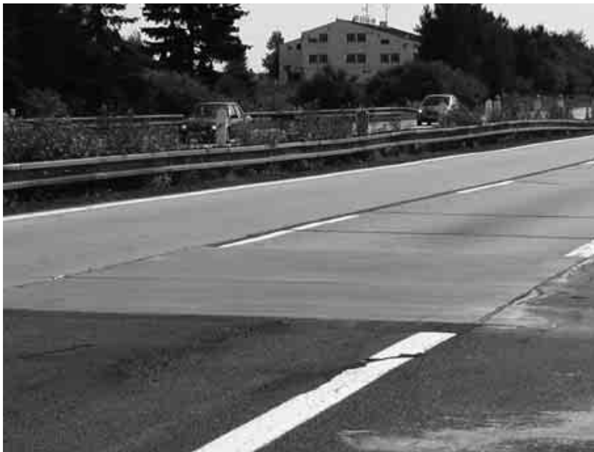
Obr. 7. Výsledkem je plnohodnotná betonová deska realizovaná v krátkém čase.
