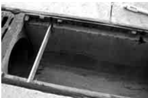
Poškození stěny otevřeného žlabu při nedostatečné dilatační spáře
