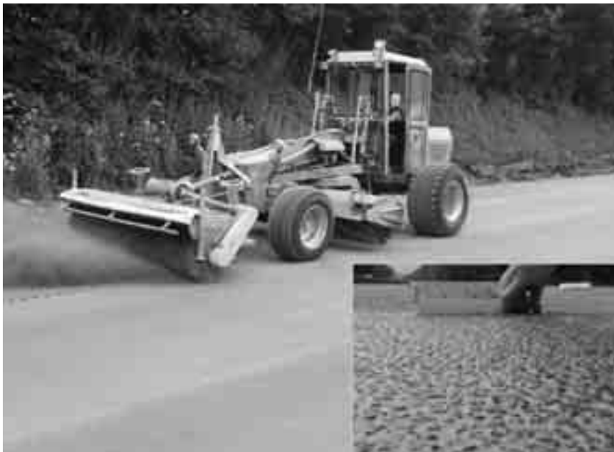
Bild 6 Ausbürsten des Oberflächenmörtels mit einem motorisierten Stahlbesen und ausgebürstete Fahrbahnoberfläche mit freiliegender Gesteinskörnung 5/8 mm
