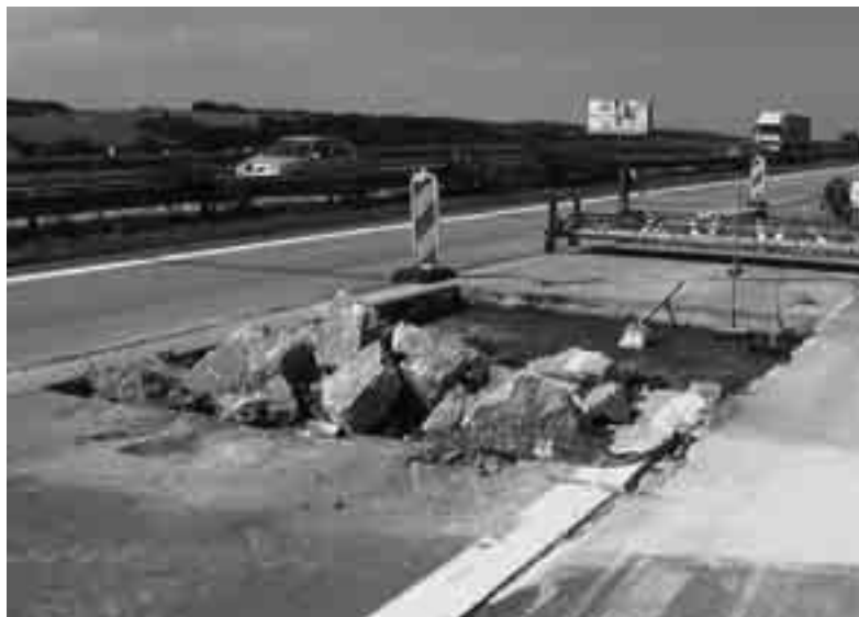
Obr. 1. Bourání staré poškozené betonové desky
