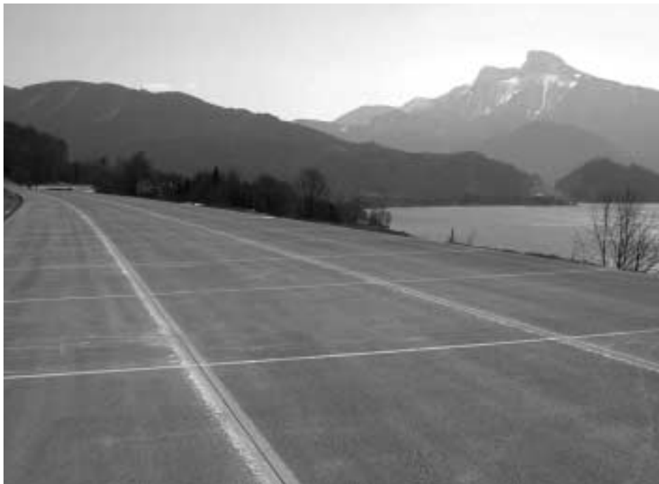
Abbildung 1: Baustelle „Mondsee“ Westautobahn A 1 – Generalerneuerung 2003.
