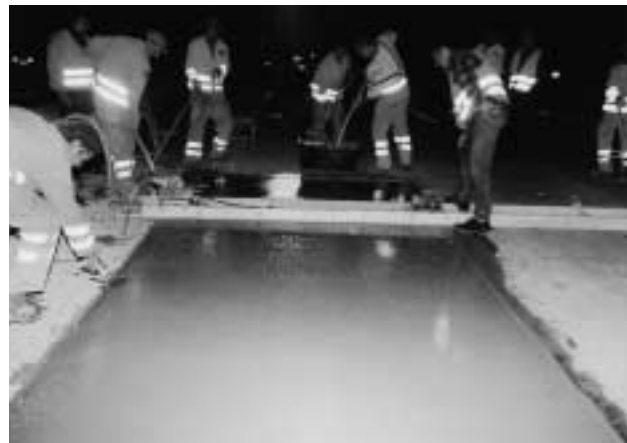
Abziehen und verdichten.
