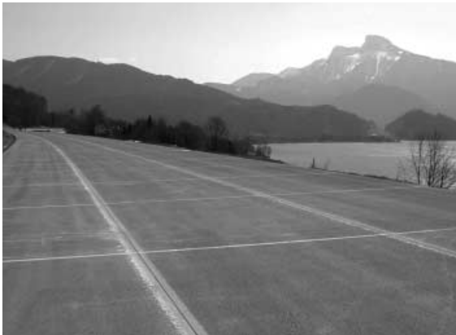
Obr. 1: Staveniště „Mondsee“ západní dálnice A 1 – generální oprava 2003.
