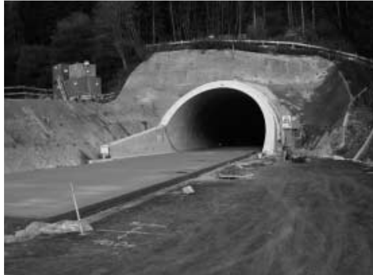
Abbildung 3: Betonfahrbahndecke im Herzogbergtunnel, Südatautobahn A 2.
