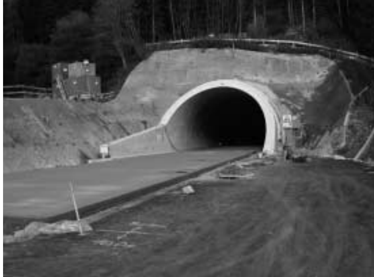
Obr. 3: Betonový kryt vozovky v Herzogberském tunelu, jižní dálnice A 2.
