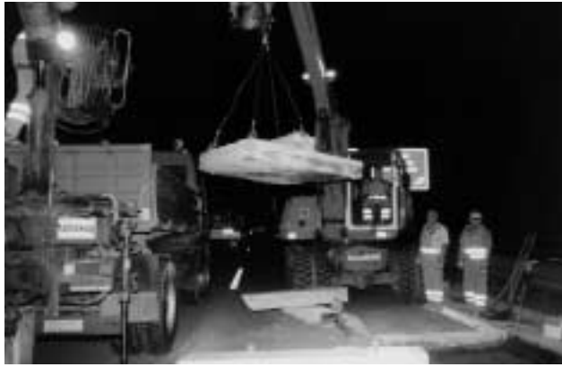
Ausheben von Platten.
