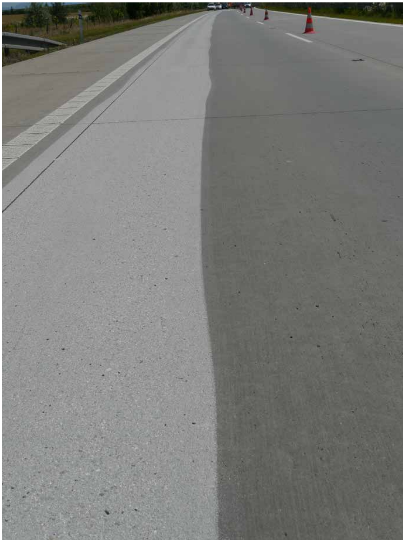
Obrázek 5) CBK otryskaný paprskem tlakové vody
