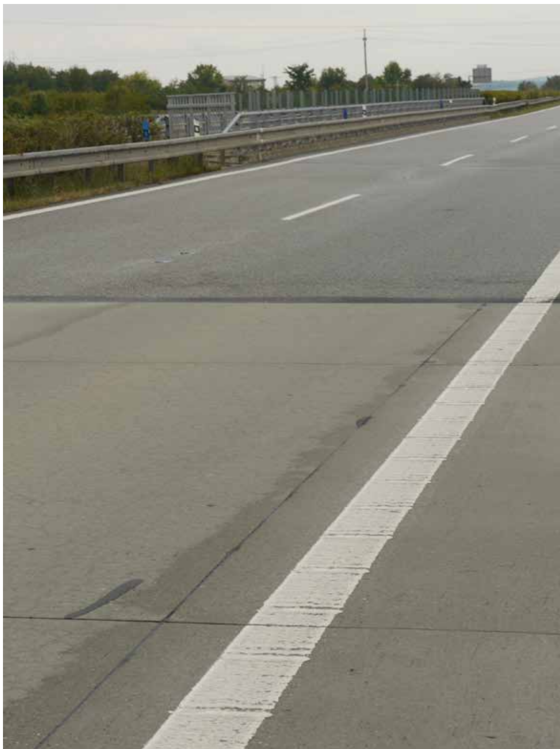
Obrázek 2) povrch CBK suchý, povrch AB i v jízdních stopách vlhký
