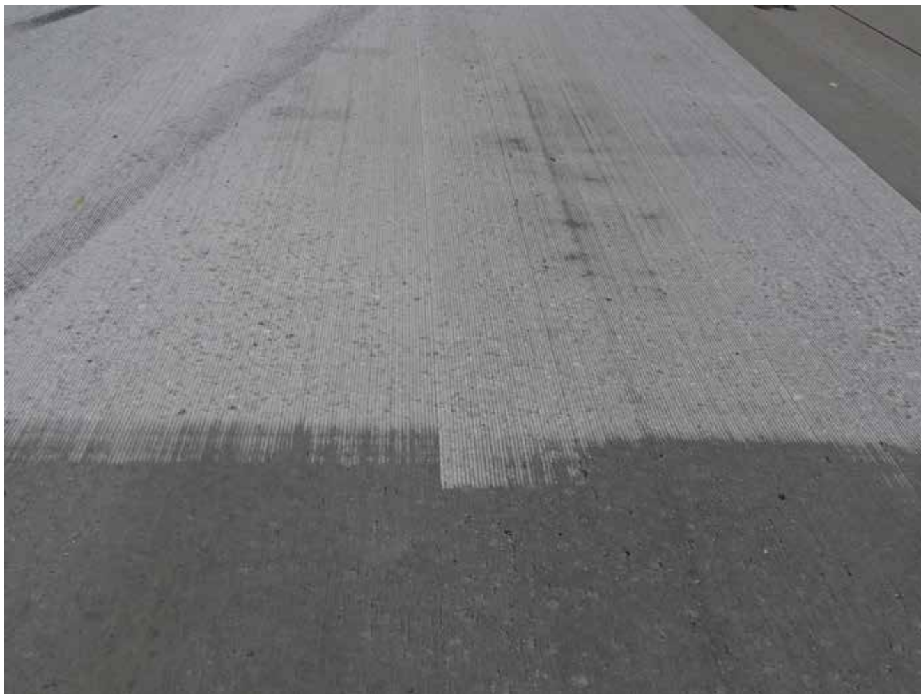
Obrázek 6) CBK broušený diamantovými kotouči
