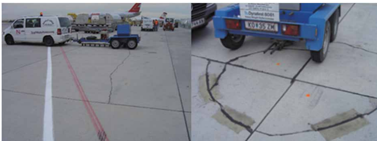
Obrázek 5: Měření pomocí deflektometru k určování průhybu vozovek tlumeným rázem (FWD)
