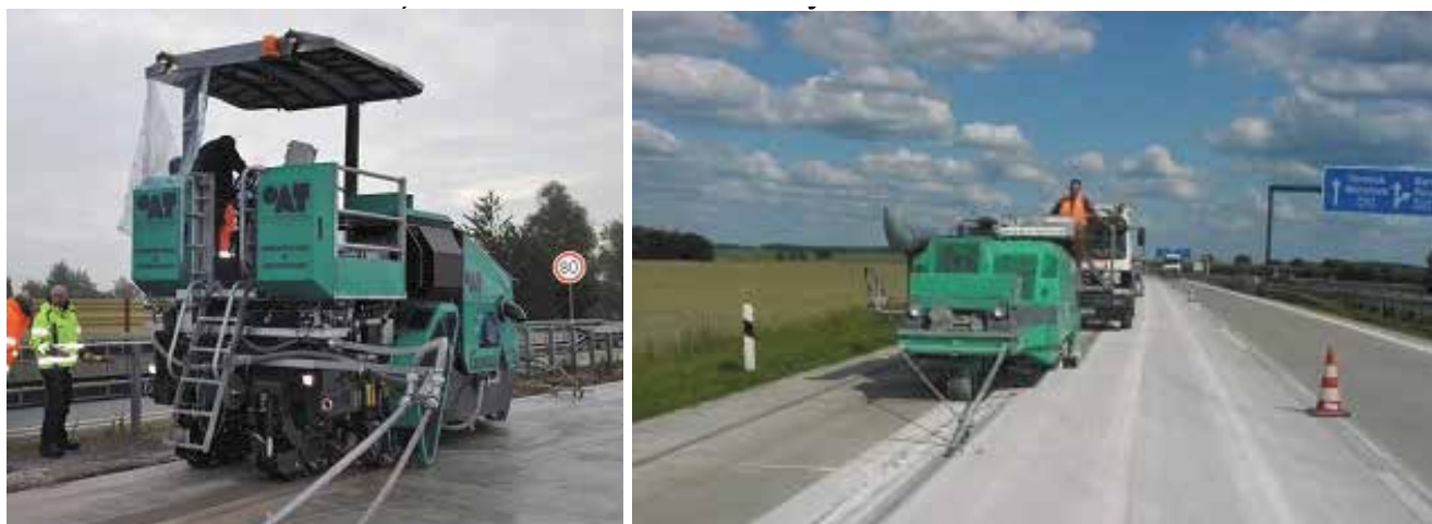
Obrázek 4) Broušení diamantovými kotouči v Německu
