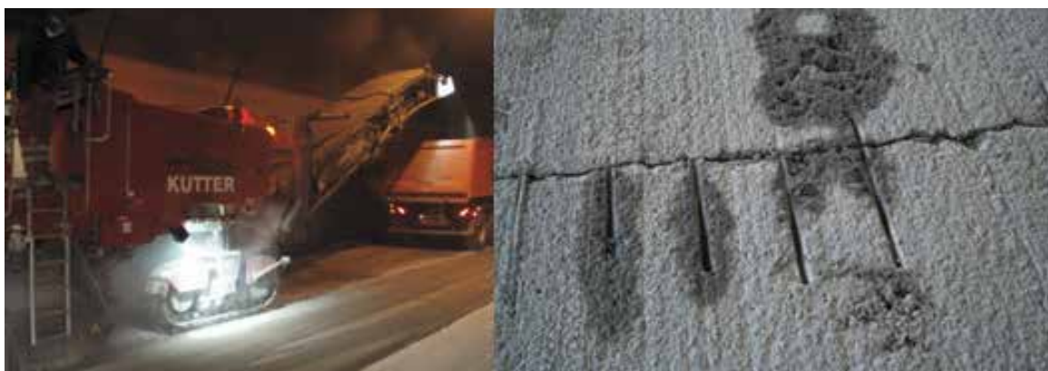
Obrázek 11: Frézování horní části stávajícího cementobetonového krytu v tloušťce 7 cm – struktura povrchu betonu po frézování
