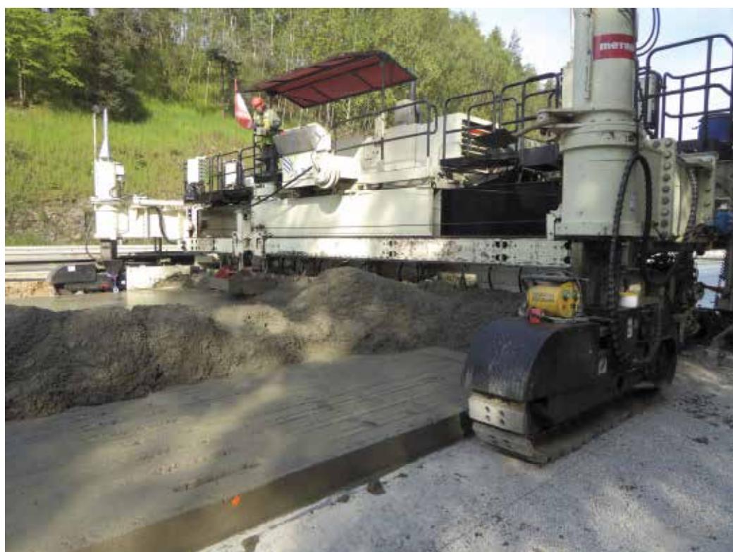
Obrázek 4) Pokládka CB krytu na úseku 3
