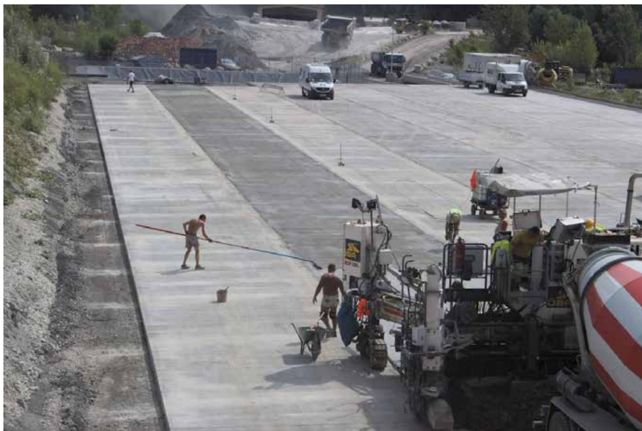
Obrázek 1) Pokládka cementobetonového krytu na zkušební ploše
