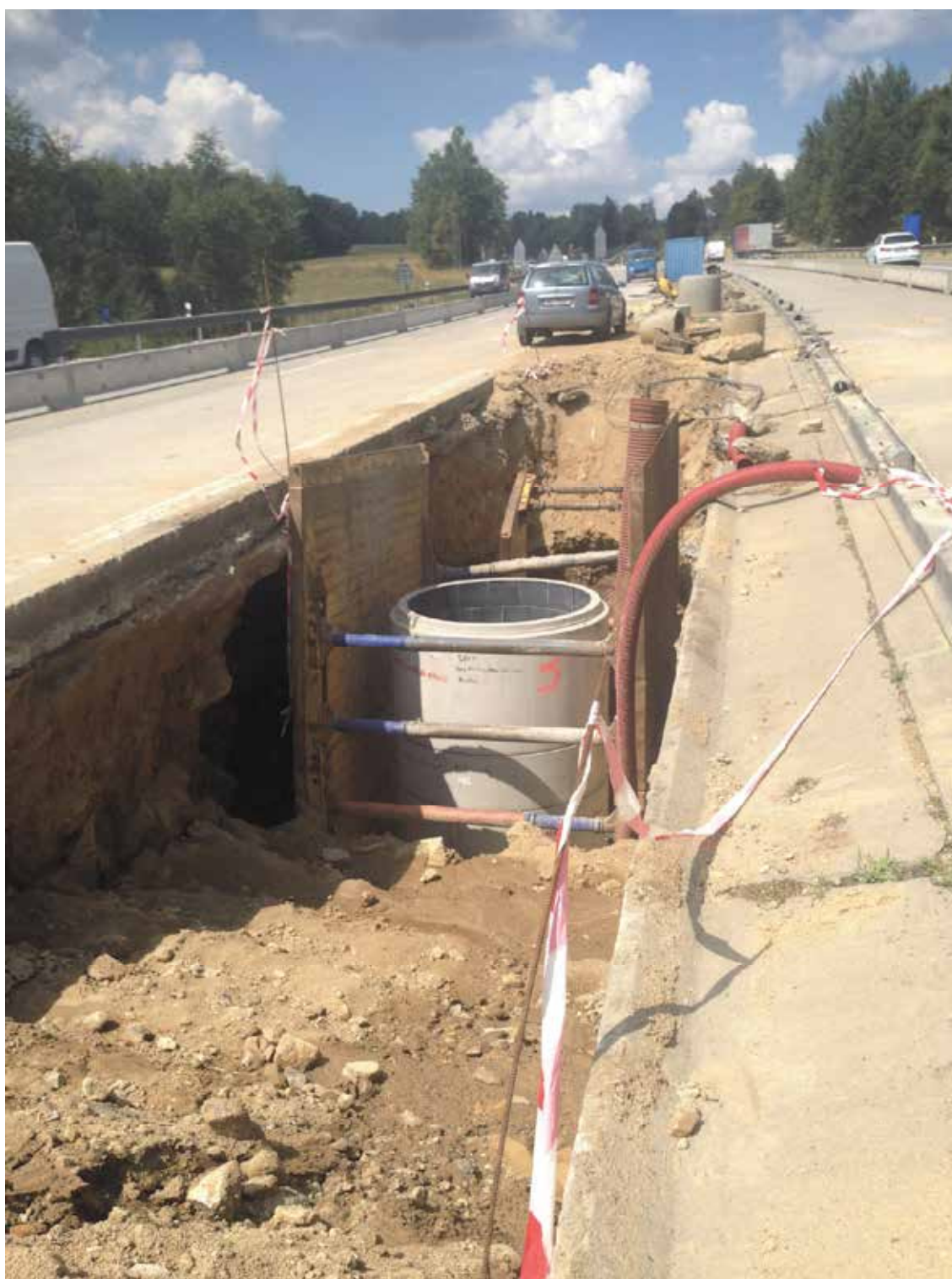
Obrázek 5) Práce ve SDP na úseku 12
