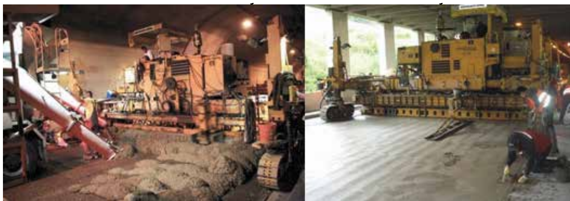
Obrázek 13: Pokládka nové vrstvy cementobetonového krytu v tloušťce 7 cm
