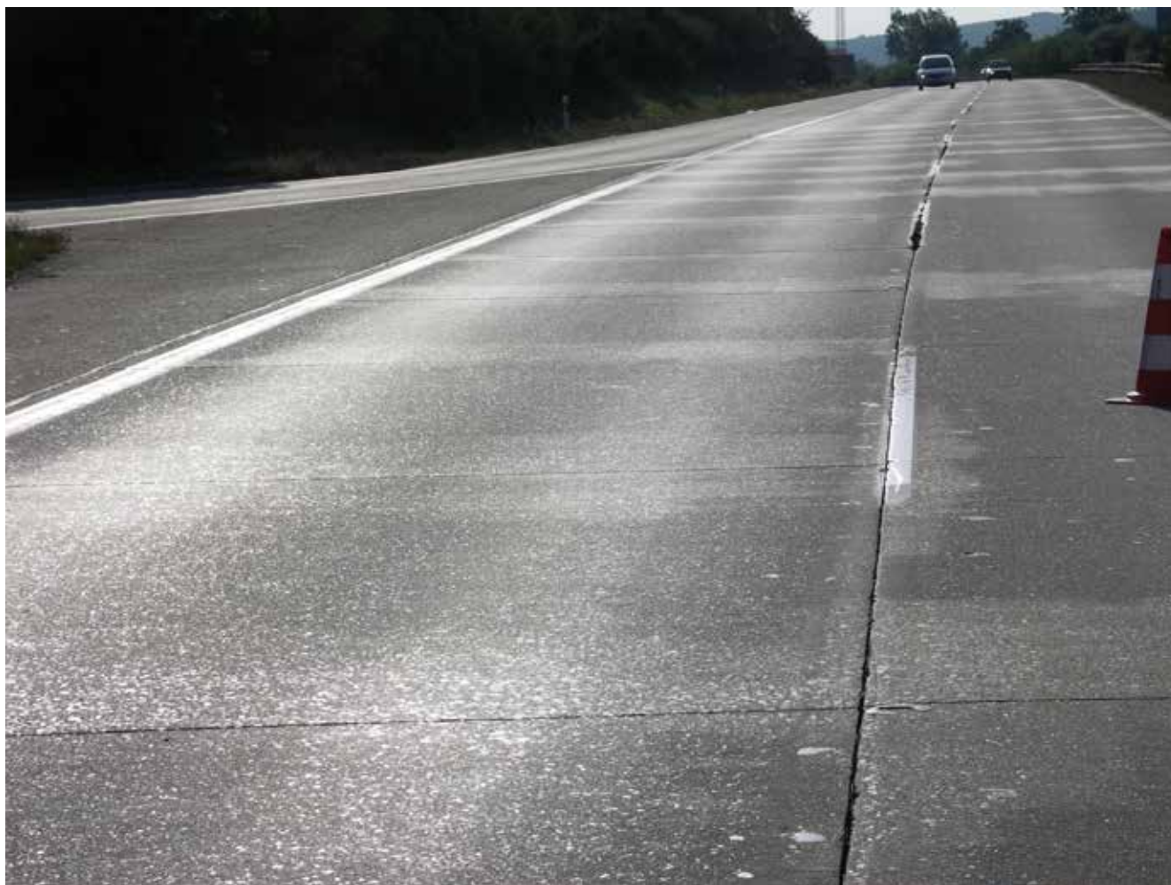
Obrázek 1) CBK s úpravou příčnou striádí a kamenivem s PSV = 44
