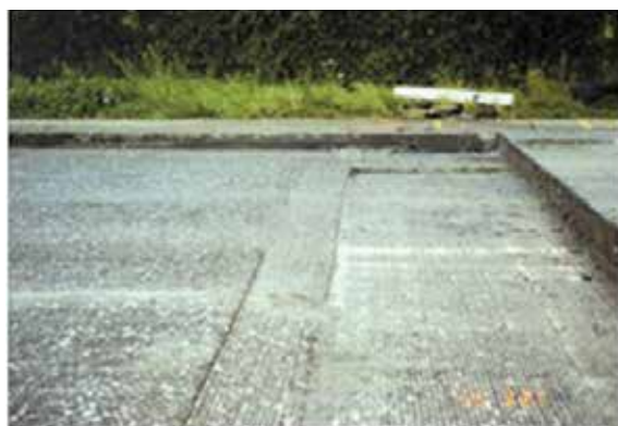
Obr. 3: Postupné zvyšování tloušťky vrstvy překrytí na přechodu mezi novým betonem a stávajícím asfaltovým krytem
