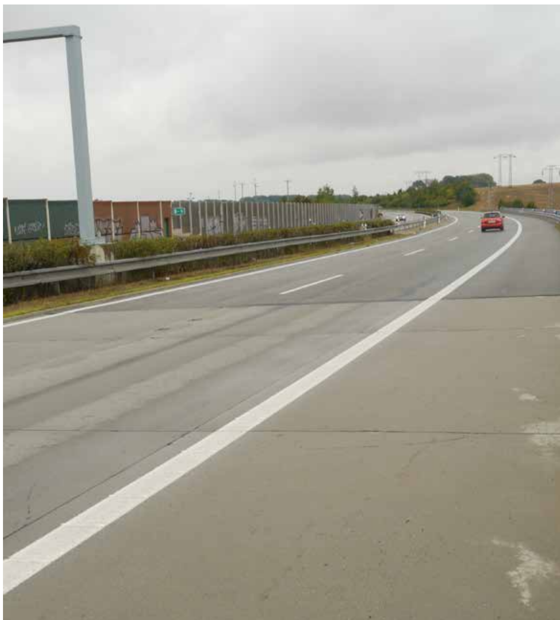
Obrázek 1) povrch CBK v jízdních stopách oschlý, povrch AB mokrý
