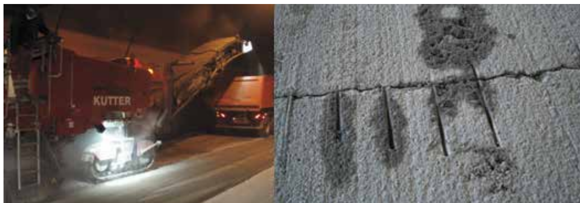
Bild 11: Fräsen des oberen Querschnittes der bestehenden Betondecke in der Dicke von 7 cm – Struktur der gefrästen Betonoberfläche
