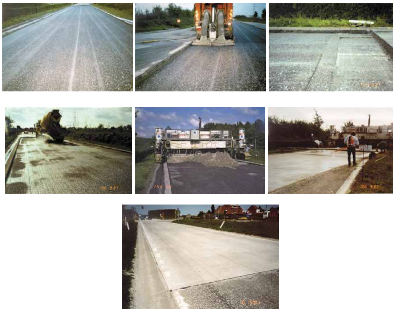
Obr. 4: Jednotlivé kroky při aplikaci TWT: vyfrézování asfaltového krytu - očištění povrchu - tloušťka v přechodové oblasti - zvlhčení povrchu – pokládka betonu finišerem - ochrana betonu - řezání spár - konečný výsledek
