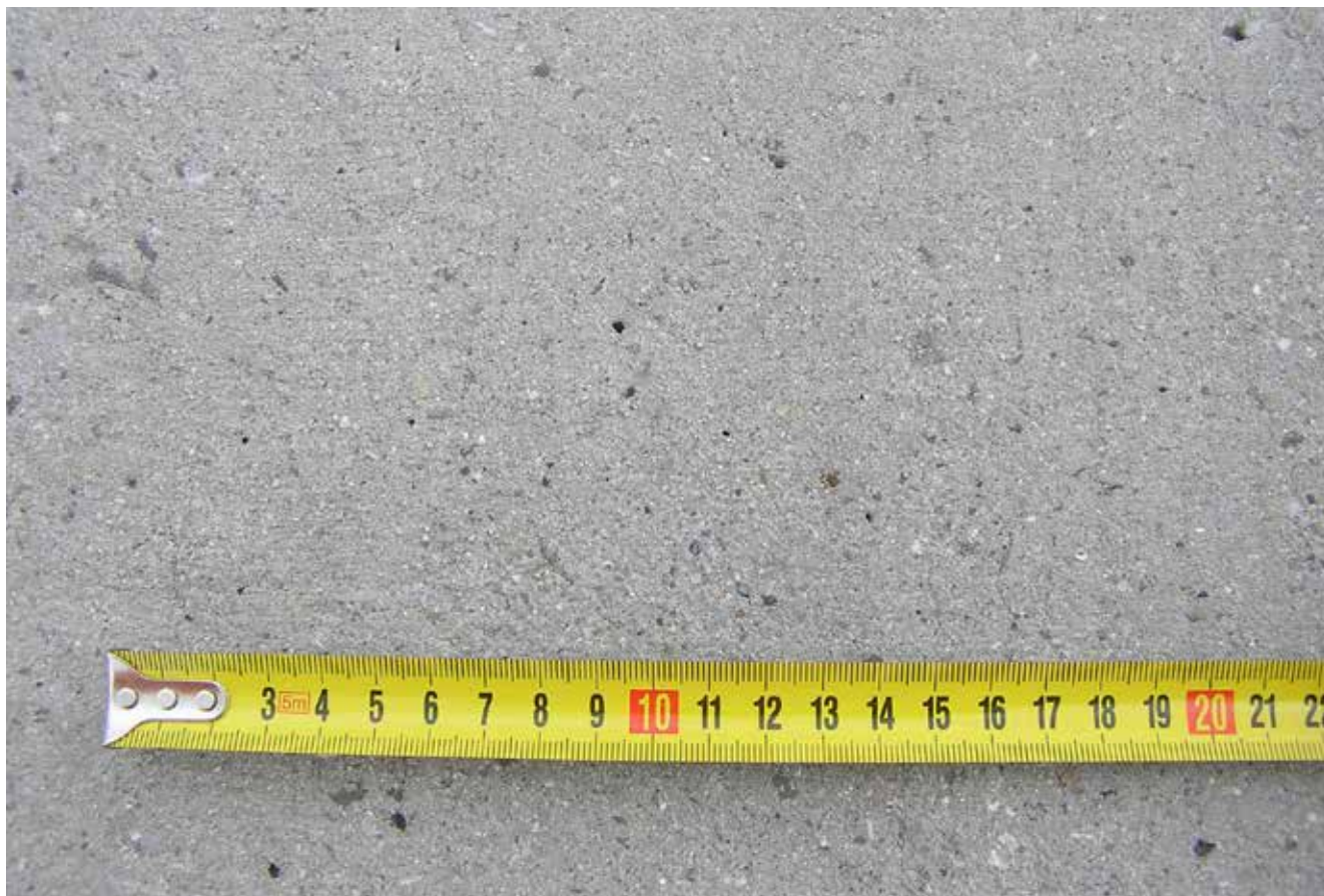
Obrázek 4) CBK otryskaný paprskem tlakové vody
