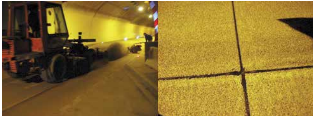
Bild 14 : Herstellen der Waschbetonstruktur – Oberflächenstruktur der fertig gestellten Betonoberfläche
