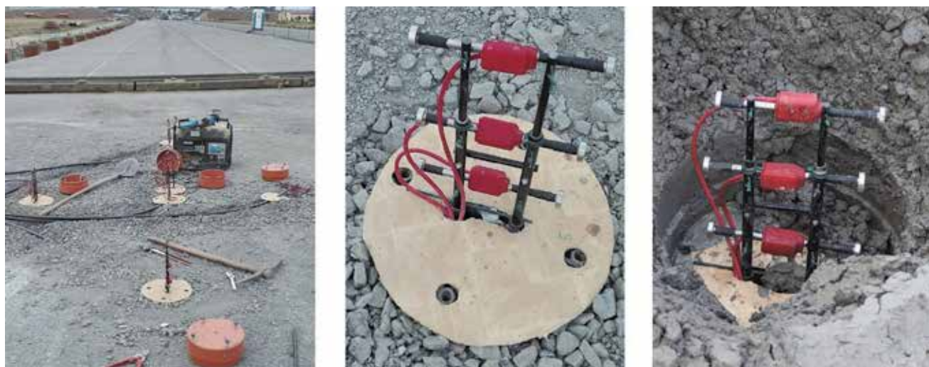
Obrázek 7) Instalace základny čidel a chrániček do MZK (vlevo a uprostřed) a opětovné obetonování po přejezdu finišeru (vpravo).
