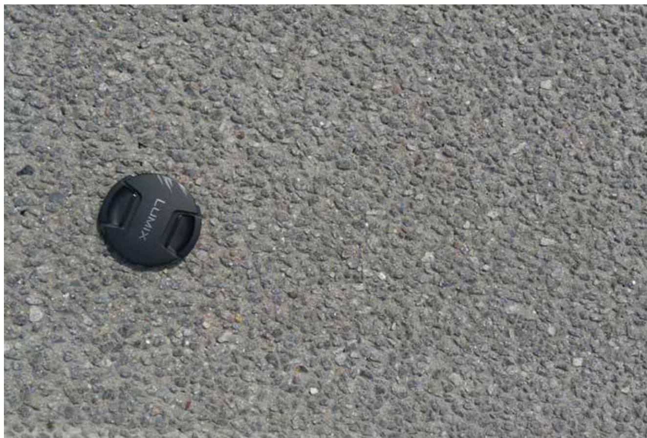
Obrázek 3) CBK s povrchovou úpravou obnažením kameniva
