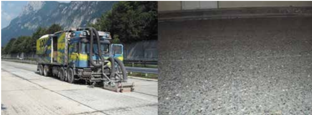
Bild 12: Hochdruckwasserstrahlen der gefrästen Betonoberfläche – Struktur der gefrästen Betonoberfläche nach dem Hochdruckwaschen
