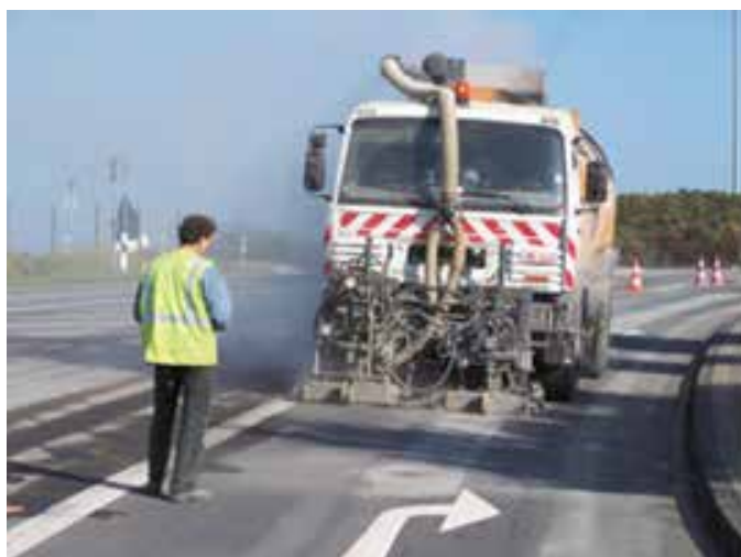
Obrázek 3: Zdrsňování povrchu cementobetonového krytu takzvanou metodou Schlagsterne
