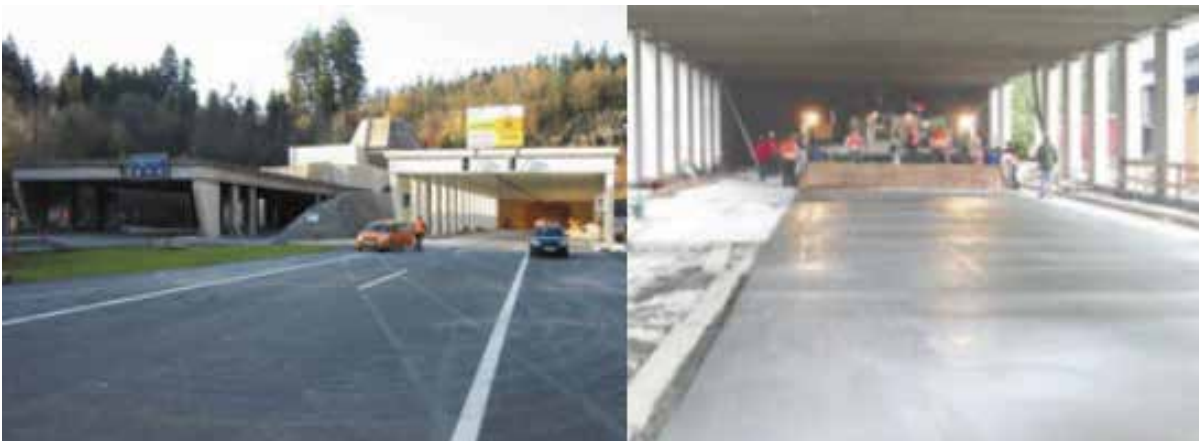
Bild 7: A14 Rheintalautobahn Ambergtunnel
