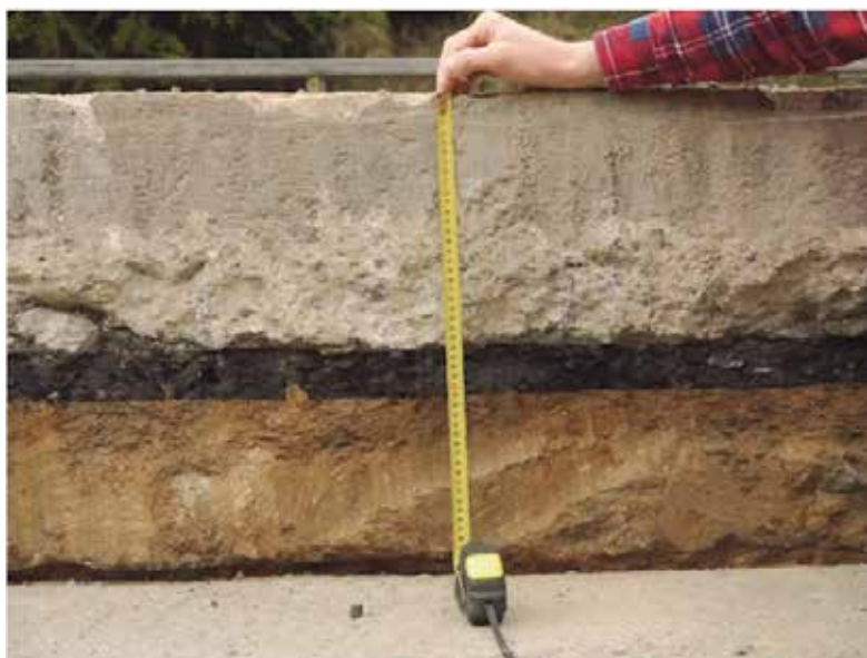
Obr. 6 CBK v úseku 04 mezi obcemi Ostředek - Šternov, uvedení do provozu 1977, demolice a foto 2017.
