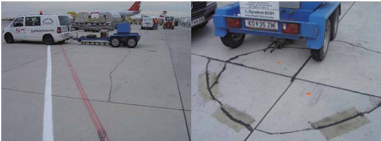
Bild 5: Messung mit dem Heavy Falling Weight Deflectometer
