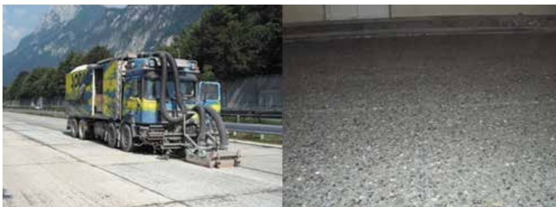
Obrázek 12: Tryskání povrchu cementobetonového krytu po odfrézování vysokotlakým vodním paprskem – struktura povrchu betonu po tryskání
