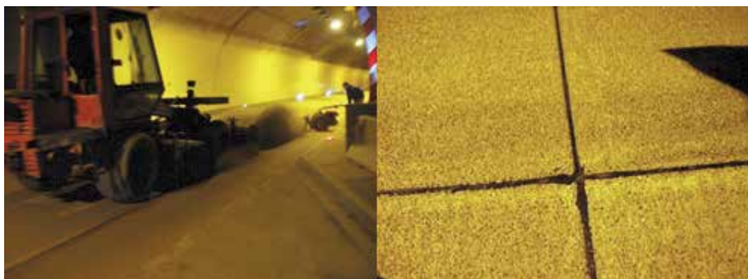
Obrázek 14: Vytváření struktury vymývaného betonu – výsledná struktura povrchu betonu
