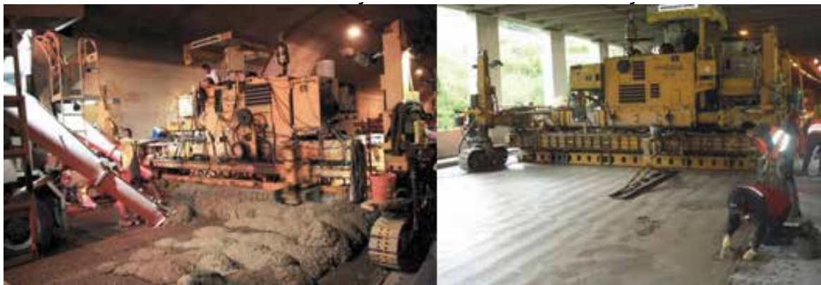
Bild 13: Herstellen der Betonschicht – Dicke 7 cm
