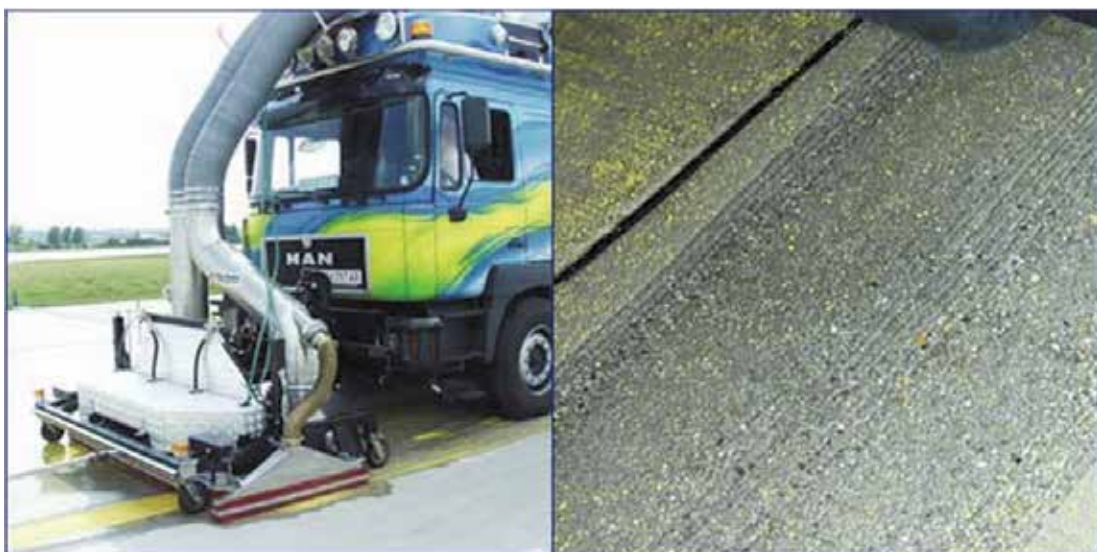
Bild 1: Höchstdruckwasserstrahlen der Betonoberfläche
