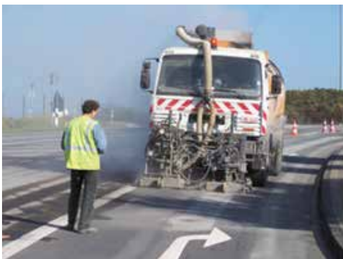
Bild 3: Aufrauen der Betonoberfläche mit dem sogenannten Schlagsternverfahren
