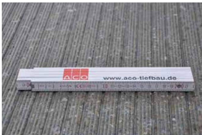
Obr. 6) Broušení a drážkování, vzdálenost mezi rýhami 20 mm (zdroj VKI)
