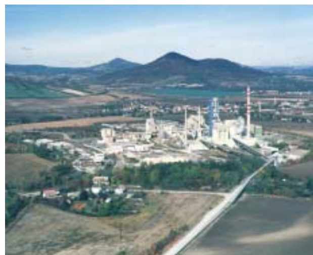
Obr. 3 Cementárna v Čížkovicích, Lafarge Cement, a. s. Fig. 3 Cement plant in Čížkovice, Lafarge Cement, a. s.
