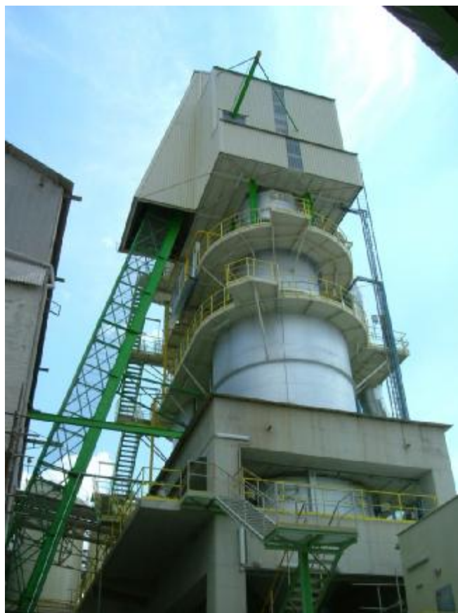
SKIPOVÝ VÝTAH OK DRÁHY
