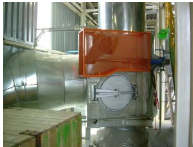
VÝSYPNÁ KLAPKA VÁPNA ODLEHČOVACÍ KLAPKA CHLAD. VZDUCHU
