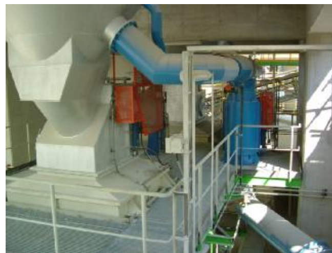
VÝSYPNÁ KLAPKA VÁPNA ODLEHČOVACÍ KLAPKA CHLAD. VZDUCHU
