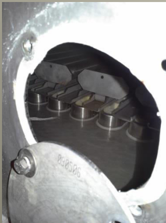
Voda na šlicblechu
