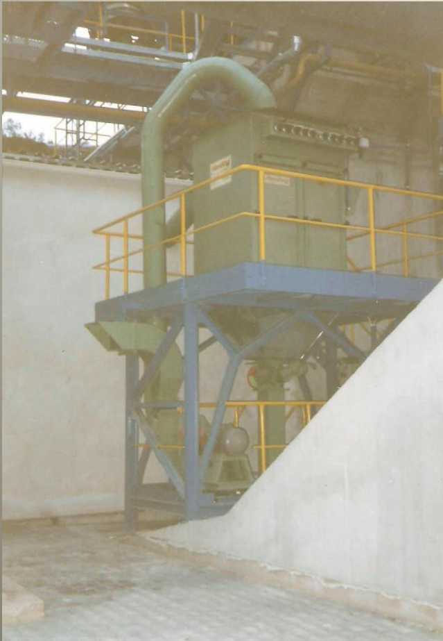
Odsávání dopravního tunelu slinku
